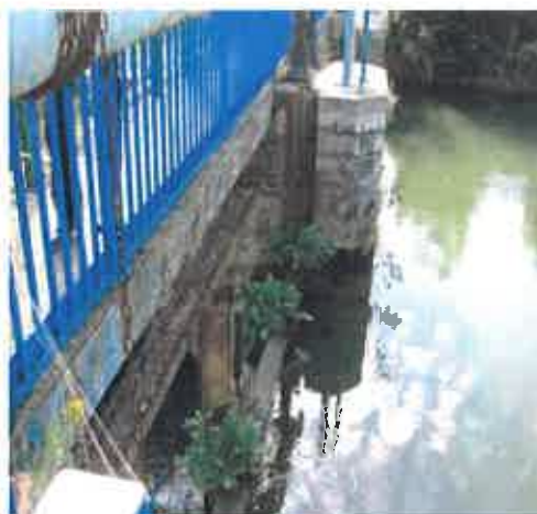
Fig11 : batardeau poutrelles
