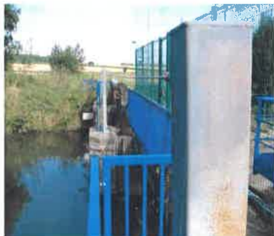
Fig 10 : barrage vue de l'amont
