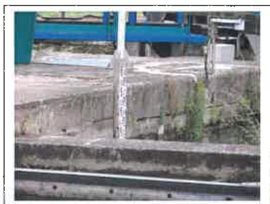
Fig 12 :Echelle à l'amont de l'écluse
