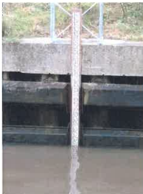
fig.17 : échelle à l'aval
