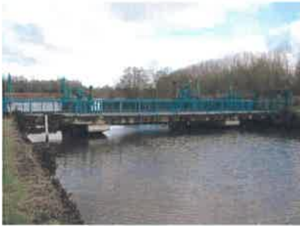
Fig.12 : Barrage vue de l'amont
