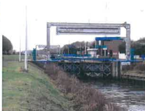
Fig.11 : Écluse vue de l'aval
