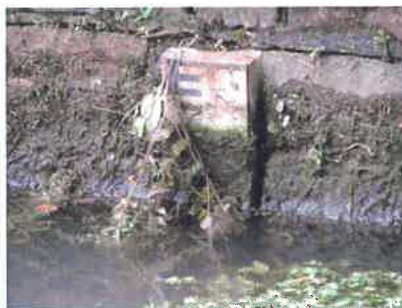
fig.16 : échelle à l'aval
