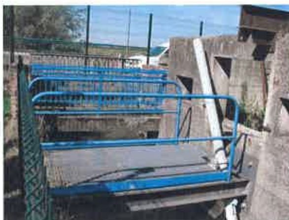
Fig.12 : Barrage passe gauche
