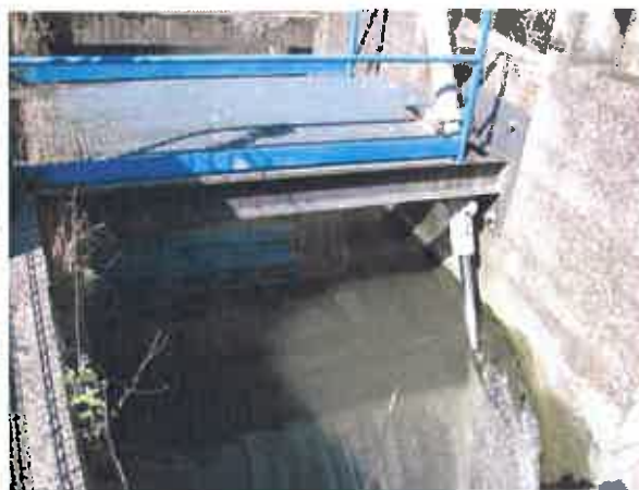
Fig.14 : Clapet vue de l'aval
