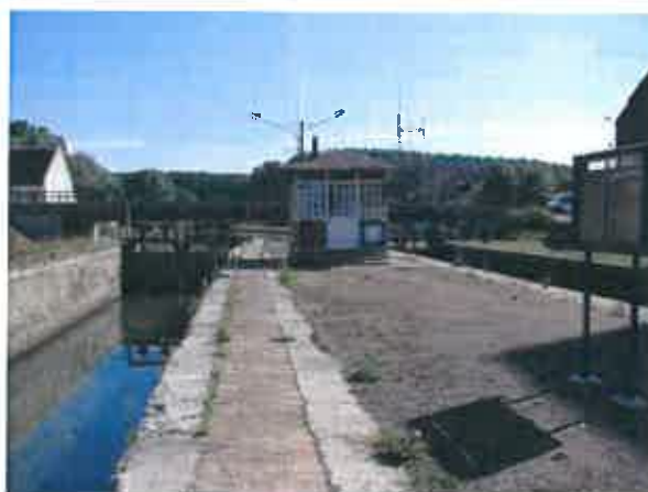
Fig.10 : Écluse vue de l'amont
