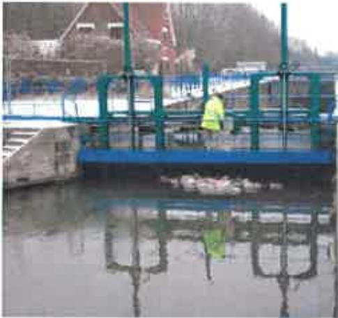
Fig.13 : Barrage vue de l'amont
