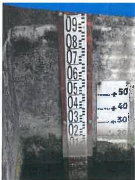
fig.19 :échelle à l'amont
