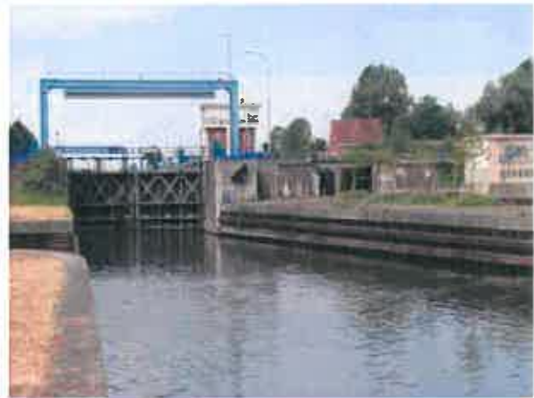
Fig.12 : Écluse vue de l'aval
