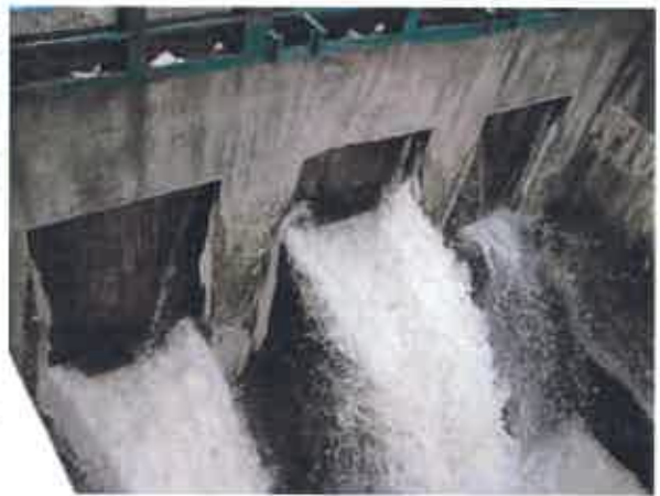
Fig.14 : Barrage vue de l'aval
