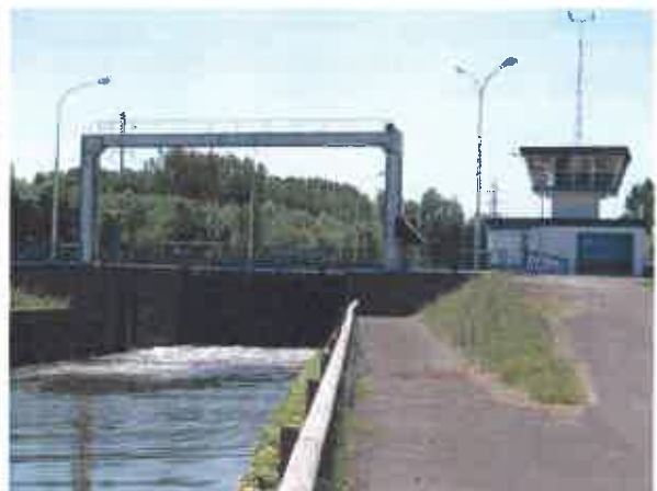
Fig.10 : Écluse vue de l'aval
