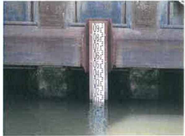
fig.16 : échelle à l'aval
