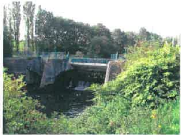
Fig.12 : Barrage vue de l'aval
