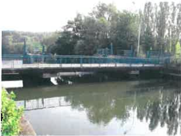
Fig.11 : Barrage vue de l'amont
