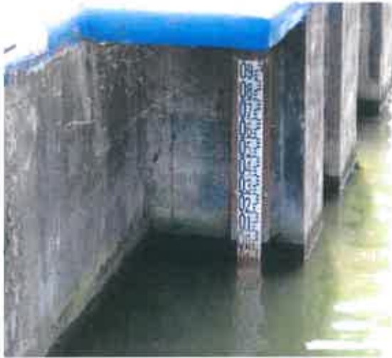
fig.15 :échelle à l'amont
