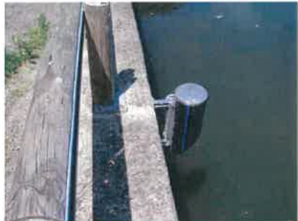
fig.18 : sonde à l'aval
