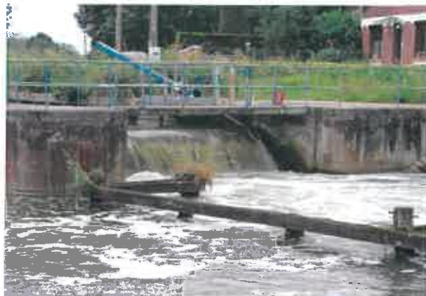
Fig.19 : barrage vue aval
