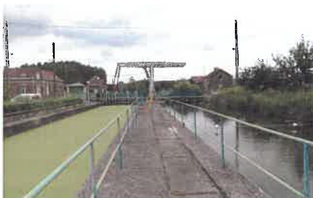
Fig.18 : écluse vue amont
