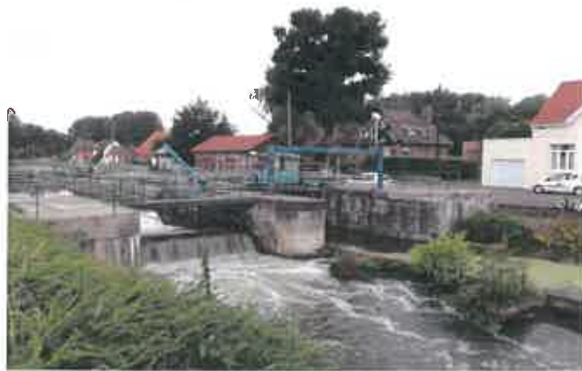
Fig.11 :barrage de Marchiennes - vue aval
