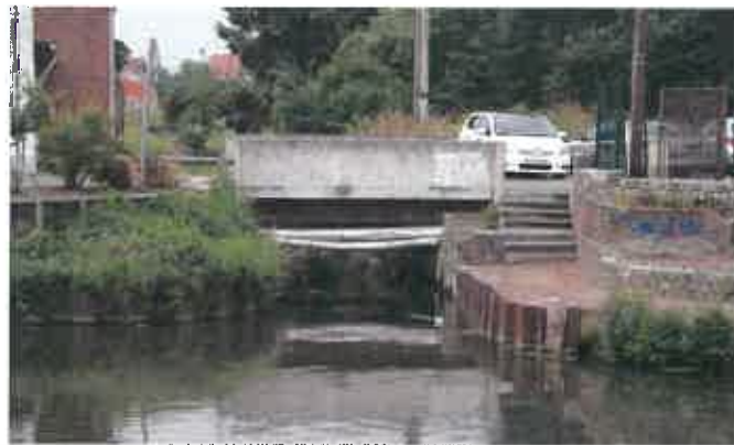
Fig.14 :Rejet de la dérivation du courant de Coutiches dans la Scarpe inférieure
