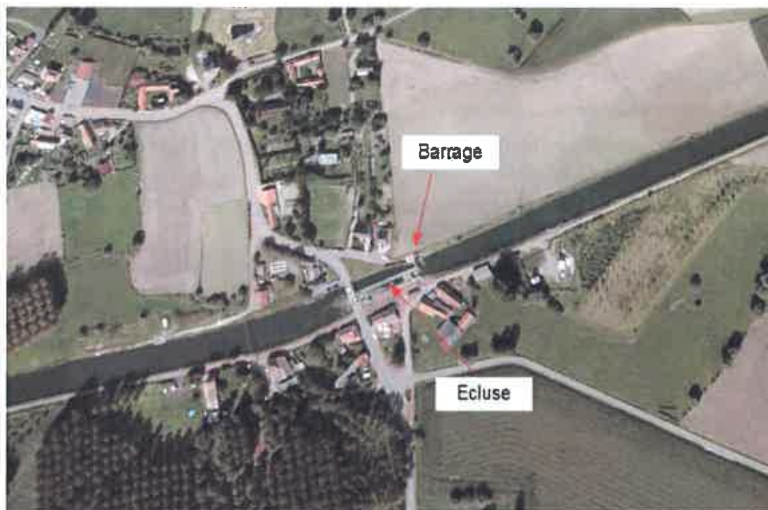
Fig. 17: localisation des ouvrages (source Google Earth)
