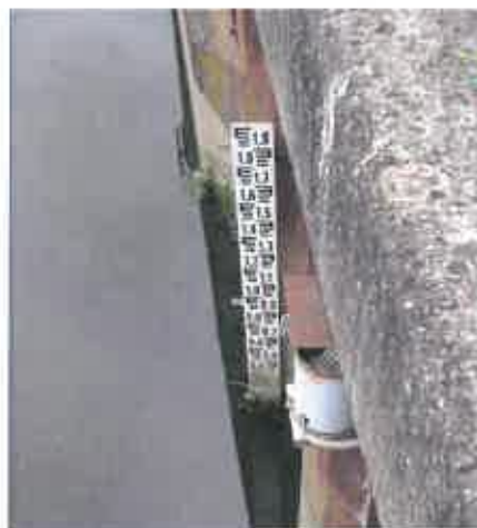
Fig. 21: échelle et sonde aval
