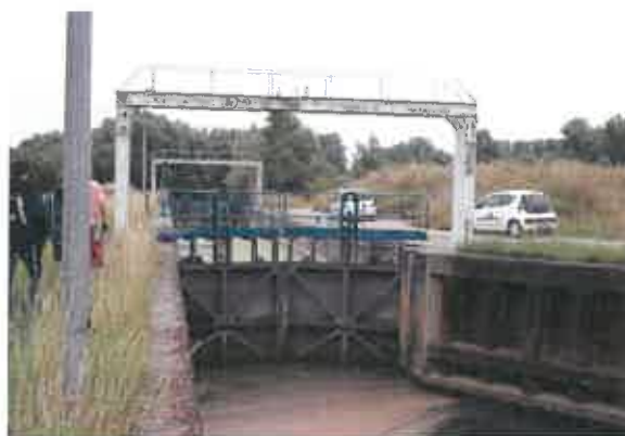
Fig.17 : écluse vue du sas - portes aval
