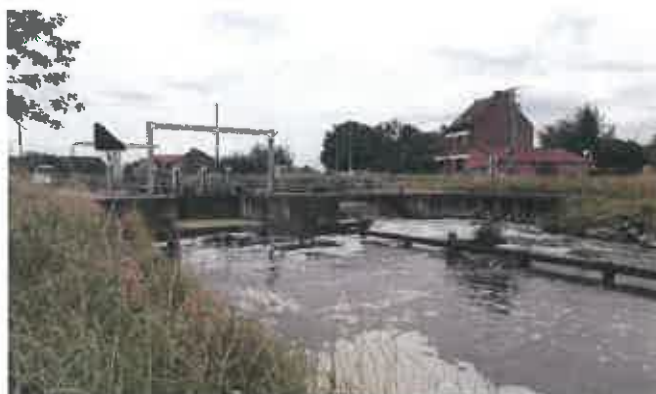
Fig.11 :barrage éclusé de Warlaing - vue aval
