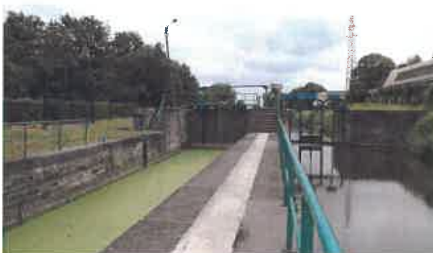
Fig.23 : écluse vue du sas - portes aval
