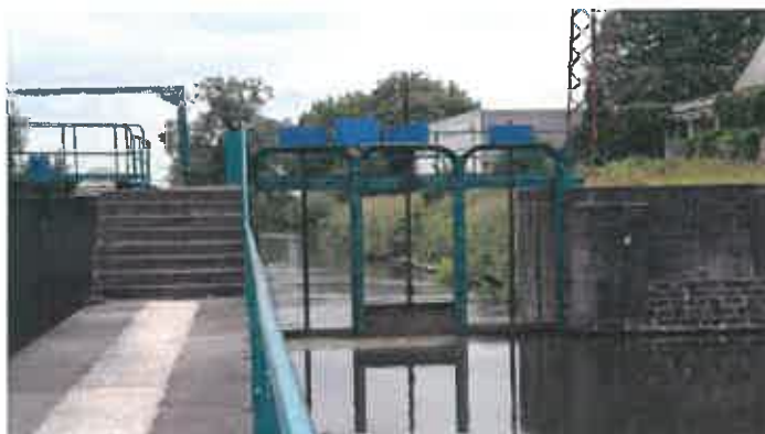
Fig.24 : barrage vue amont
