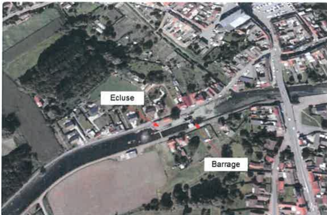
Fig.22 : localisation des ouvrages (source Google Earth)
