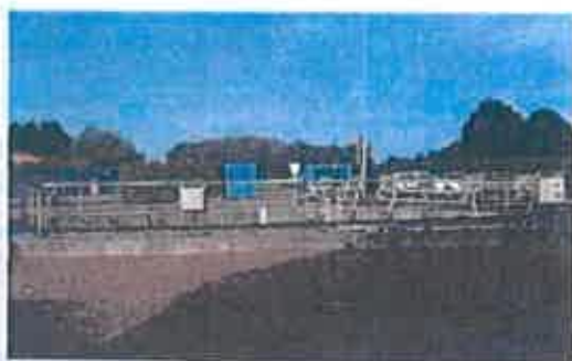
vue générale de la station
