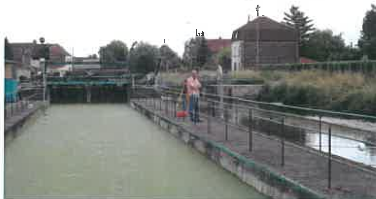
Fig.23 : écluse vue amont
