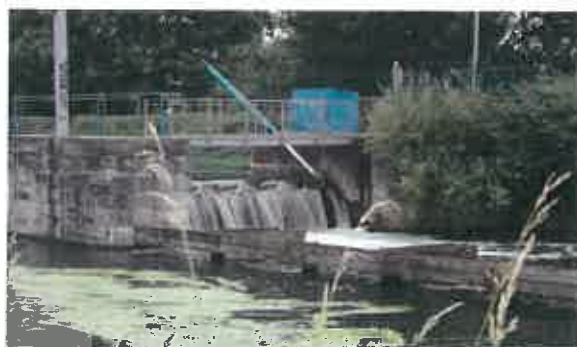
Fig.11 :barrage de Lallaing - vue aval
