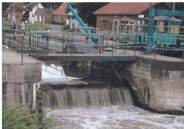
Fig.24 : barrage vue aval
