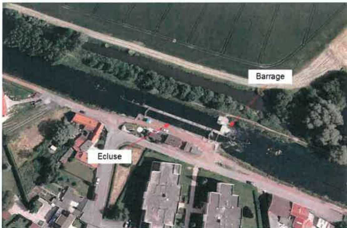
Fig.25 : localisation des ouvrages (source Google Earth)
