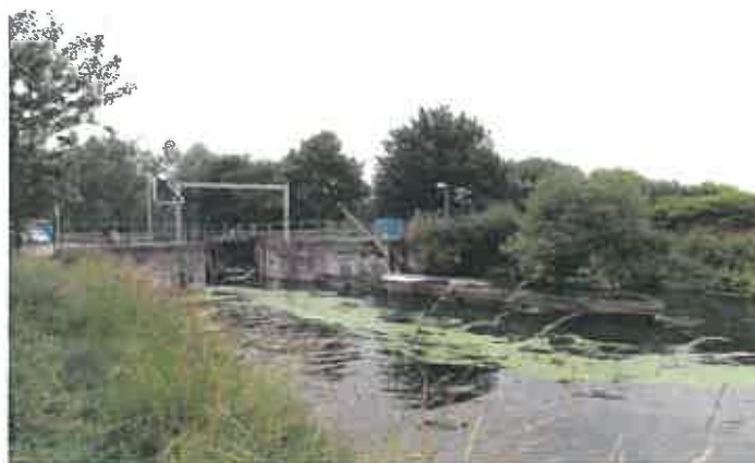
Fig.26 : écluse vue aval
