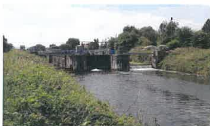
Fig.11 :écluse de Fort de Scarpe - vue aval
