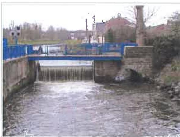
Fig.8 : Photo du clapet ouvert
