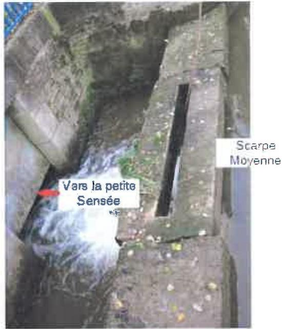
Fig.11 : Vanne de bief à l'amont de l'écluse de Lambres
