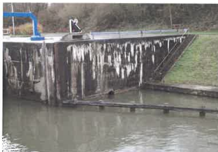
Fig.15 : exutoire de l'ouvrage de transfert par aqueduc en rive gauche
