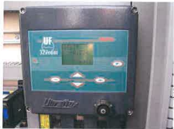
Fig.25 : photo du débitmètre
