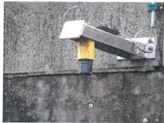
fig.23 : sonde à l'aval
