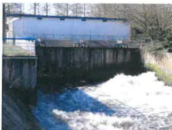
Fig.16 : Barrage vue de l'aval
