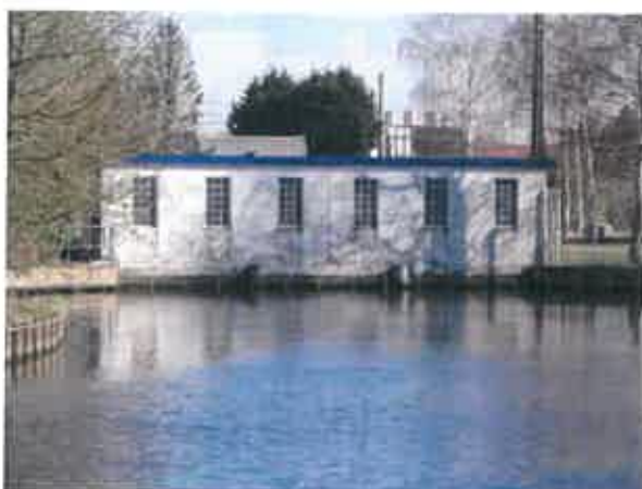
Fig.15 : Barrage vue de l'amont
