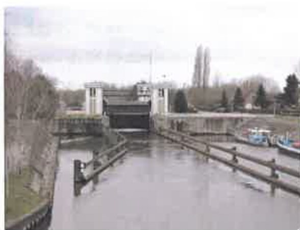
Fig.14 : Écluse vue de l'aval
