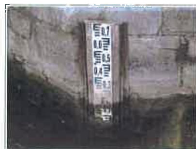
fig.16 : échelle à l'amont
