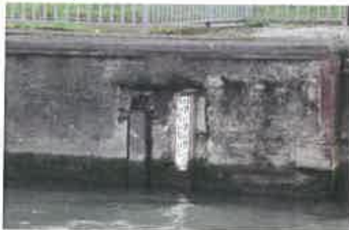
Fig.14 : Echelle limnimétrique amont
