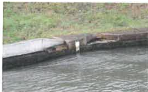
Fig.15 : Echelle limnimétrique aval
