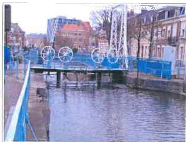
Fig.9 : Vue amont de l'écluse
