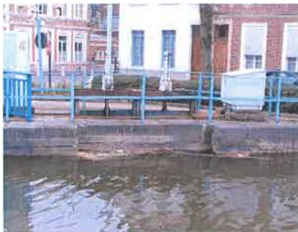
Fig.11 :Photo du barrage (aqueduc souterrain)
