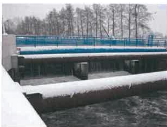
Fig.14 : Barrage vue de l'aval
