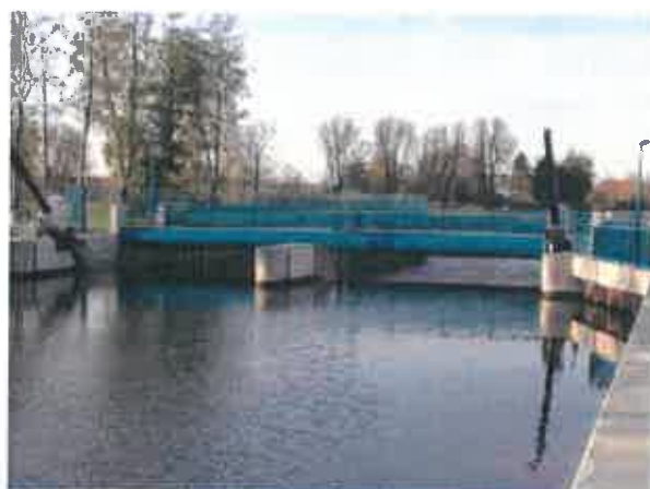
Fig.13 : Barrage vue de l'amont
