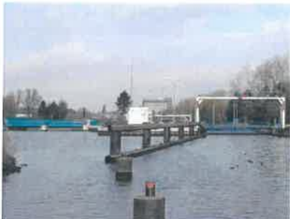
Fig.11 : Écluse vue de l'amont
