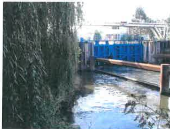
Fig.12 : Écluse vue de l'aval
