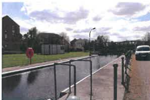
Fig.12 : Ecluse - vue du sas
