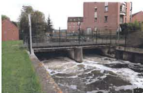
Fig.13 : Barrage vue aval (en rive gauche)
