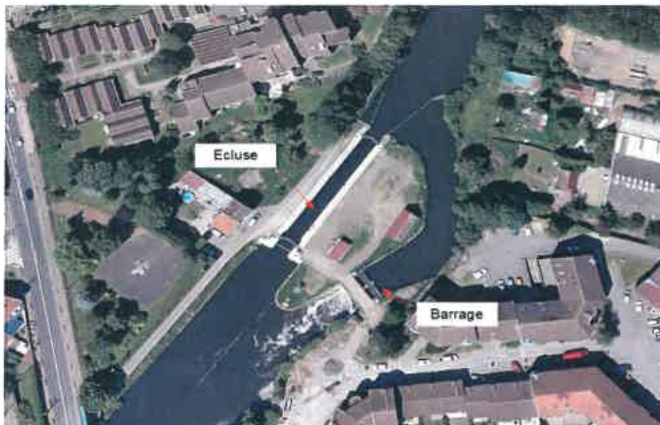
Fig.11 : Localisation des ouvrages (source Google Earth)
