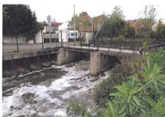
Fig.9 : Barrage de Marcq
