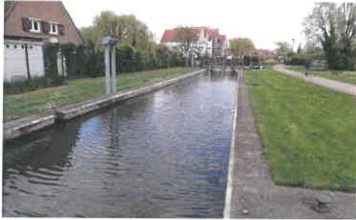
Fig.12: Ecluse - vue du sas
