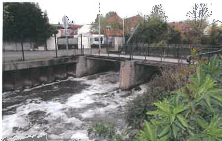
Fig.13 : Barrage vue aval (en rive droite)
