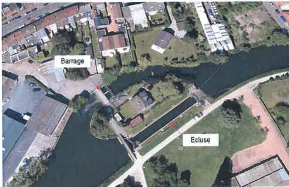
Fig.11 : Localisation des ouvrages (source Google Earth)
