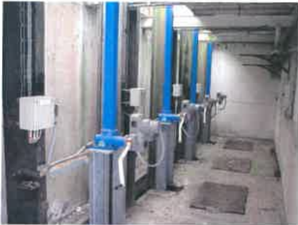
Fig.12 : détails vannes du barrage
