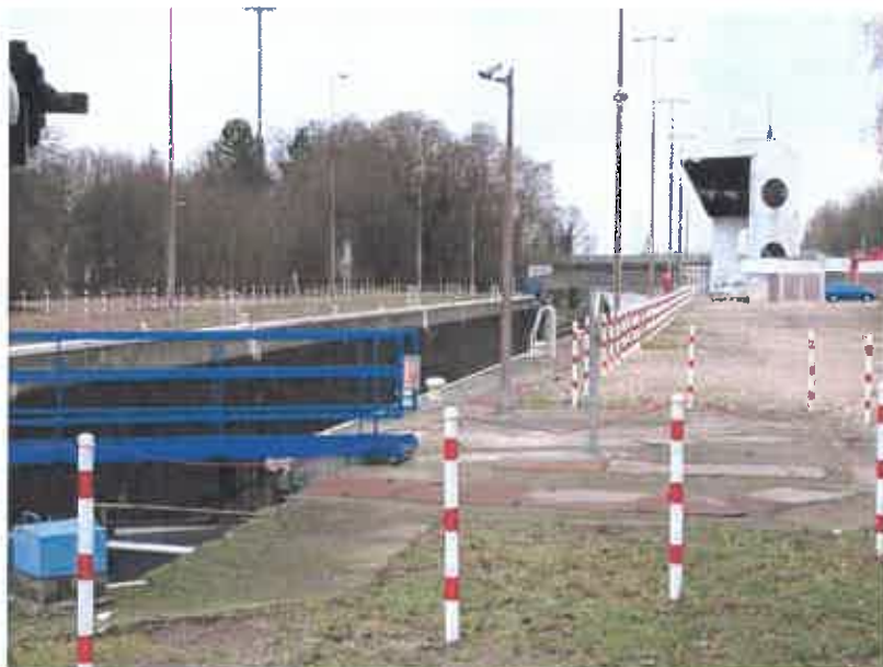
Fig.11 : Écluse vue de l'amont
