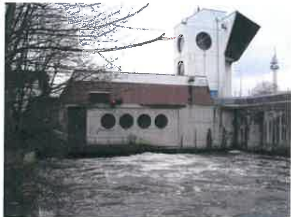
Fig.13 : Barrage vue de l'aval
