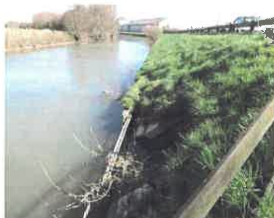
Fig.12 :Rejet de la Busnes dans la Lys canalisée à Saint-Venant
