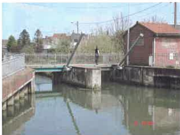
Fig.27 : barrage vue amont
