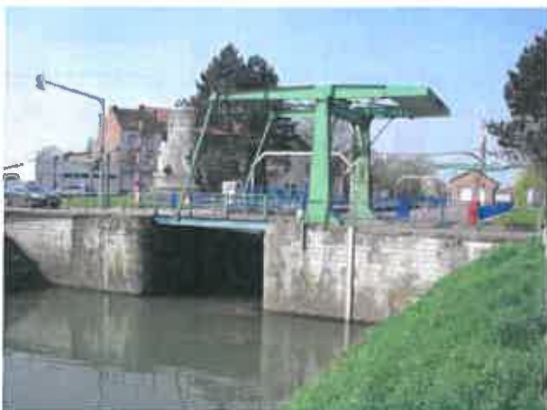
Fig.25 : écluse vue aval
