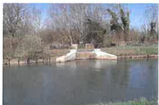
Fig.15 : cadre 1300/2300 – rejet vers la Lys canalisée
