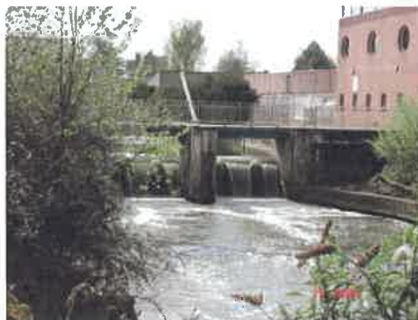
Fig.28 : barrage vue aval
