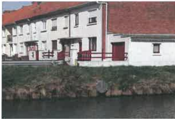
Fig.19 :exemple de rejet dans la Lys canalisée aux abords d'une zone urbanisée
