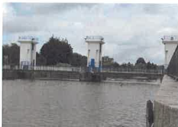
Fig.19 : barrage vue amont
