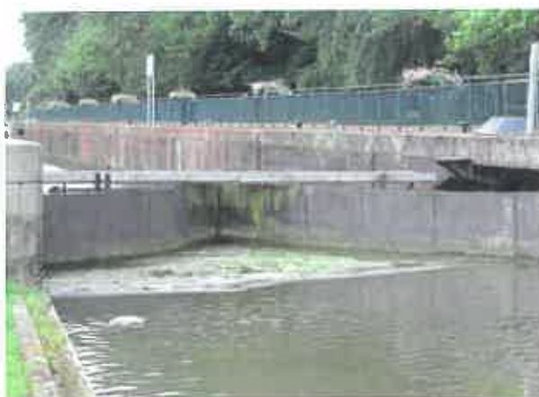
Fig.17 : écluse vue amont
