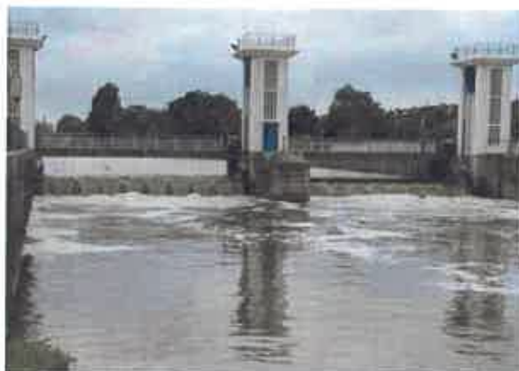
Fig.20 : barrage vue aval
