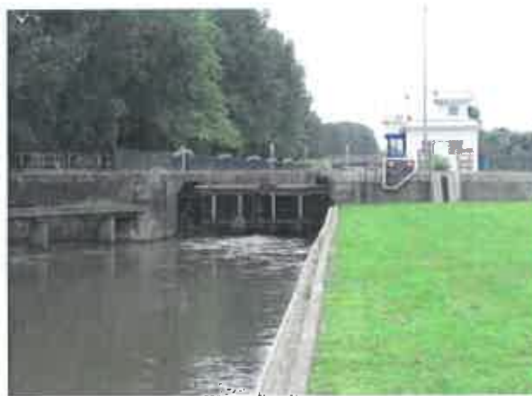
Fig.18 : écluse vue aval
