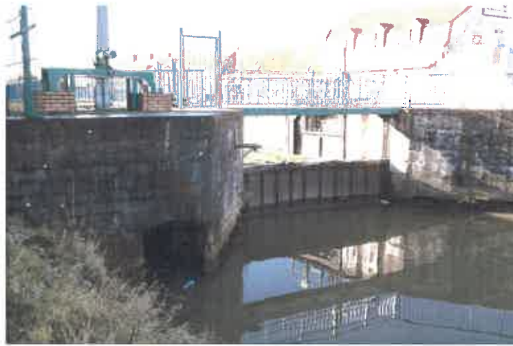
Fig.11 : vanne de Lynck – vue aval à côté de l'écluse batardeée
