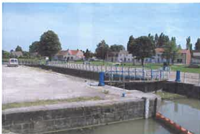
Fig.15 : Ecluse de Bourbourg – vue amont
