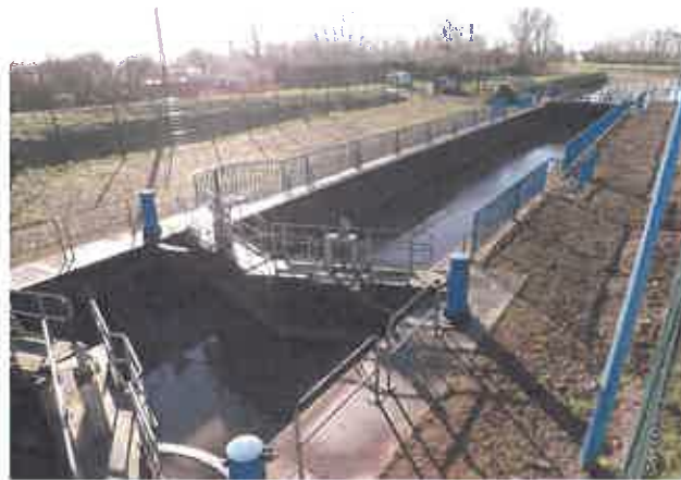
Fig.9 : Ecluse de Guindal
