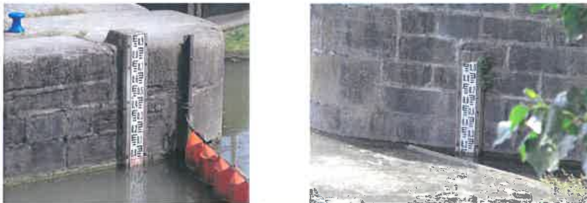
Fig.17 : Vue de l'échelle amont et aval de l'écluse de Bourbourg
