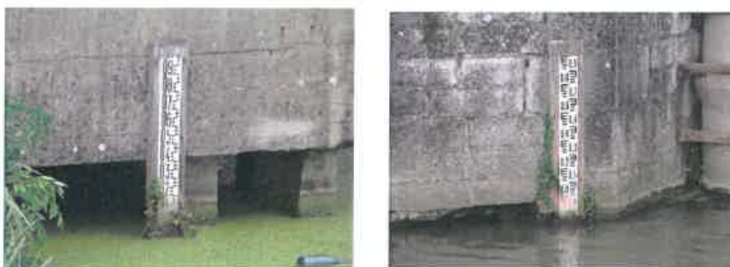
Fig.14 : Vues des échelles amont et aval
