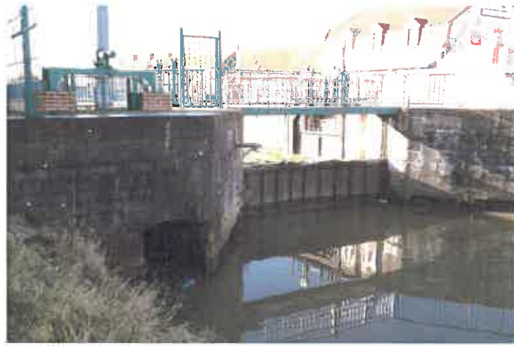
Fig.11 : vanne de Lynck – vue aval à côté de l'écluse batardée
