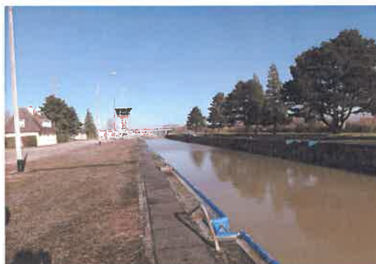
Fig.21 :Ecluse de Watten
