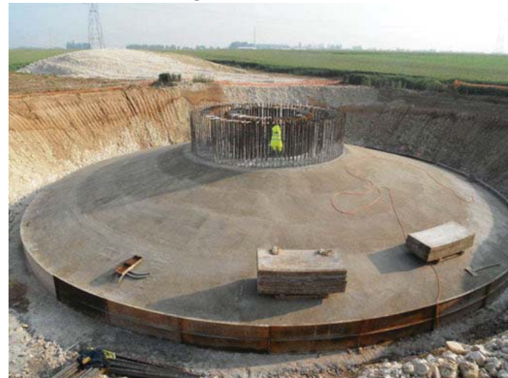
Photographie 12 : Coulage du béton sur l'armature
