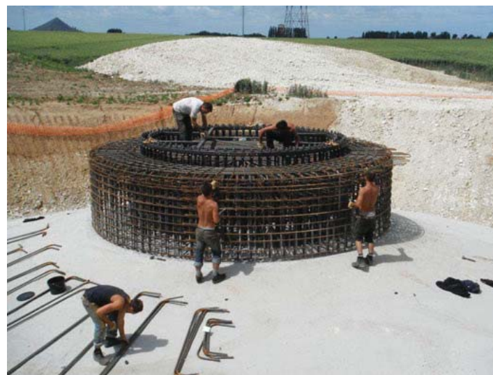
Photographie 10 : Armature d'acier de la fondation
