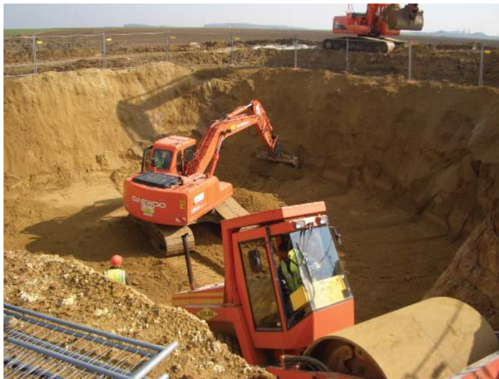
Photographie 18 : Excavation et terrassement pour l'installation des fondations
