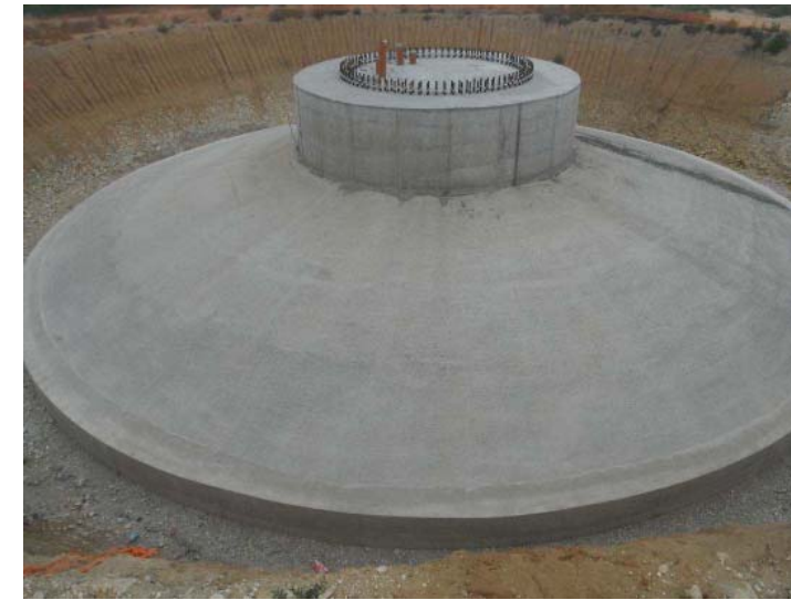
Photographie 14 : Fondation complète
