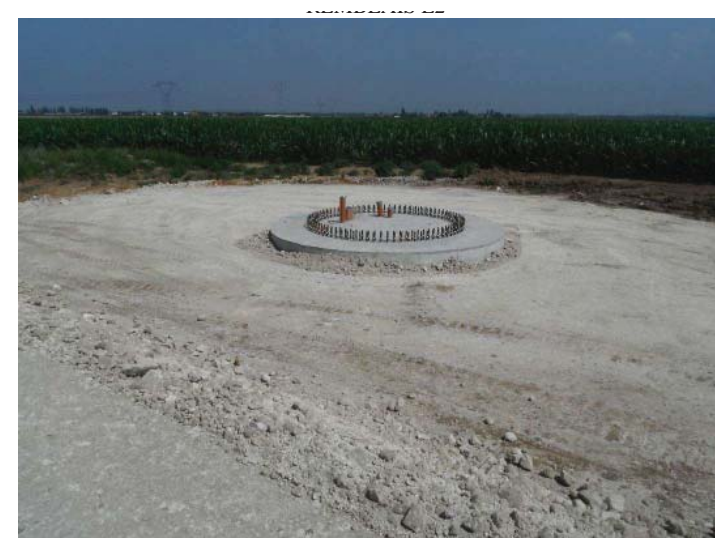
Photographie 16 : Embase de l'éolienne, fondation enterrée
