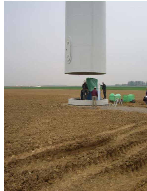
Photographie 22 : Ajustement de la première section de mât sur l'embase
