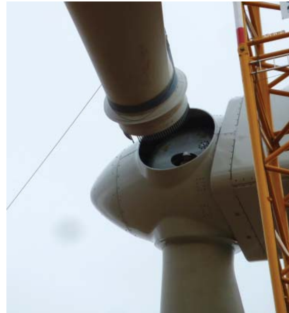
Photographie 29 : Fixation de la pale au moyeu
