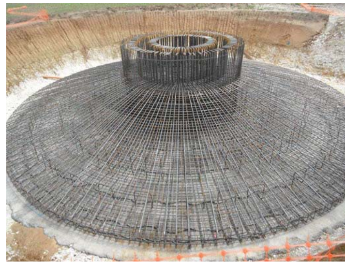
Photographie 11 : Ferrailage de la fondation finalisé
