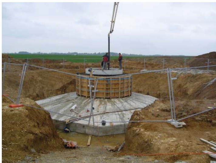
Photographie 19 : Coulage du béton solidarissant la virole au massif
