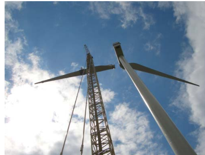
Photographie 23 : Assemblage d'une pale
