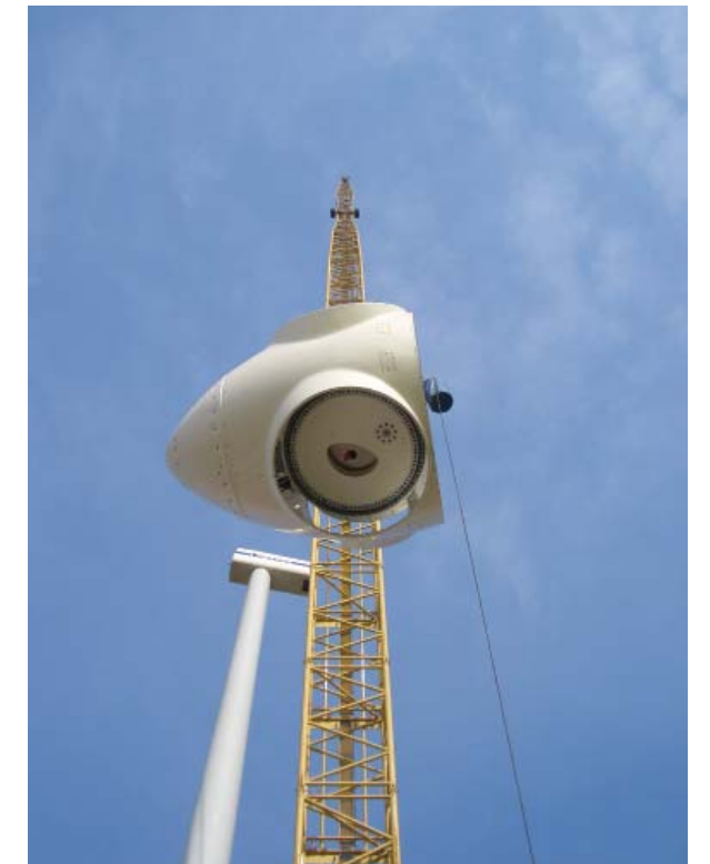
Photographie 25 : Levage du moyeu en fonte
