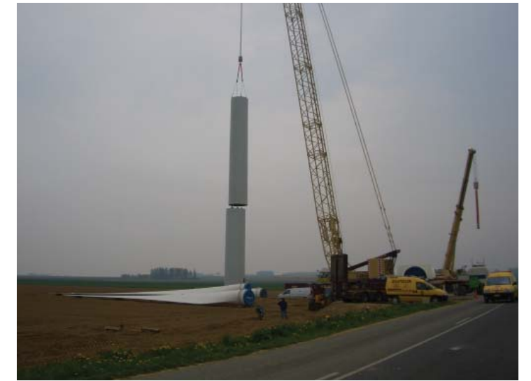
Photographie 24 : Assemblage des deux premières sections du mât
