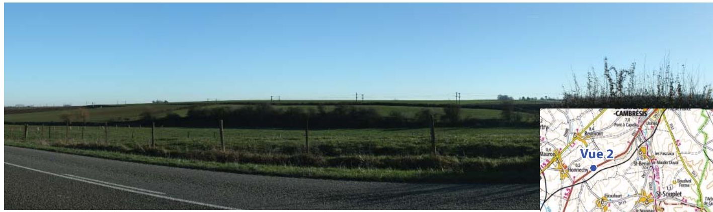
Photographie 2 : vue du site d'implantation depuis la RD 21, sur la commune d'Honnechy (à 710 m de la première éolienne)
