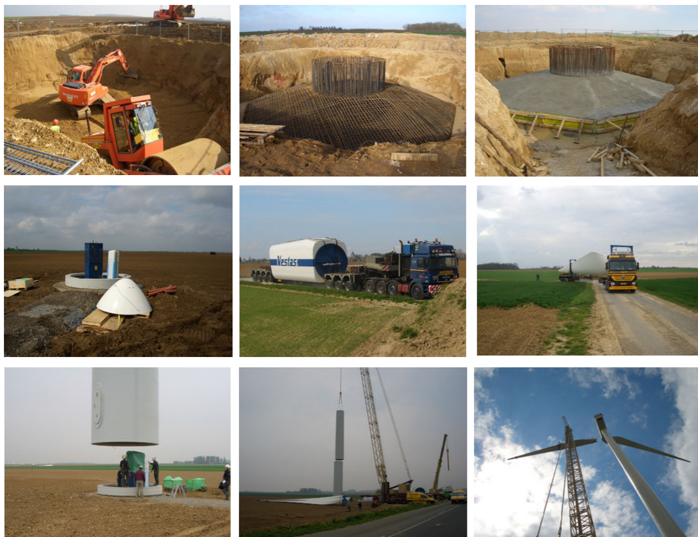
Photographie 1 : Aperçu des différentes phases de travaux
