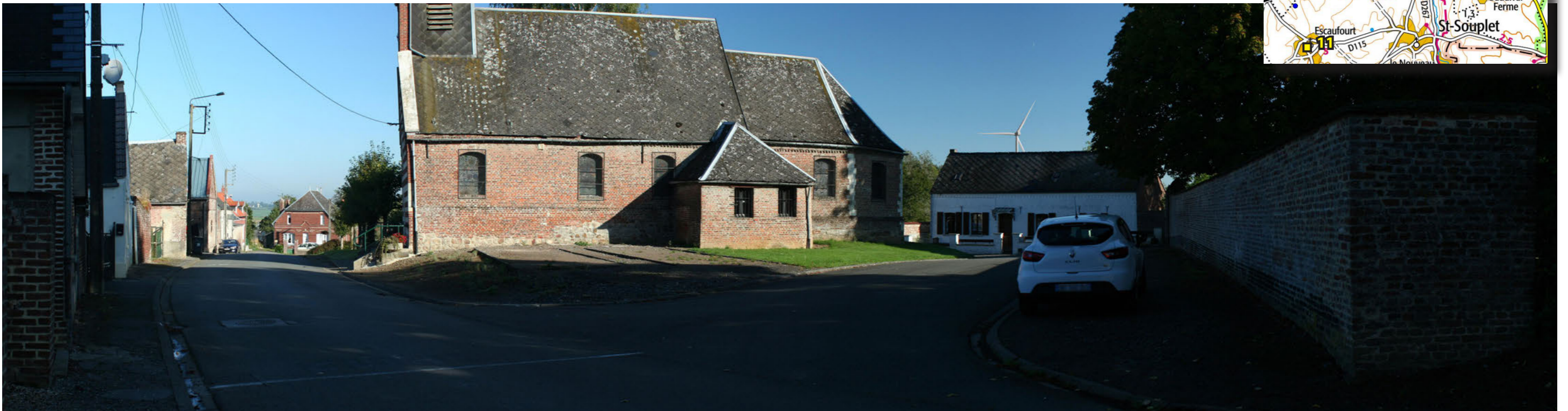
Photographie 11 : Depuis le centre d'Escaufourt - à environ 900 m de l'éolienne la plus proche (A6 non visible ici)
