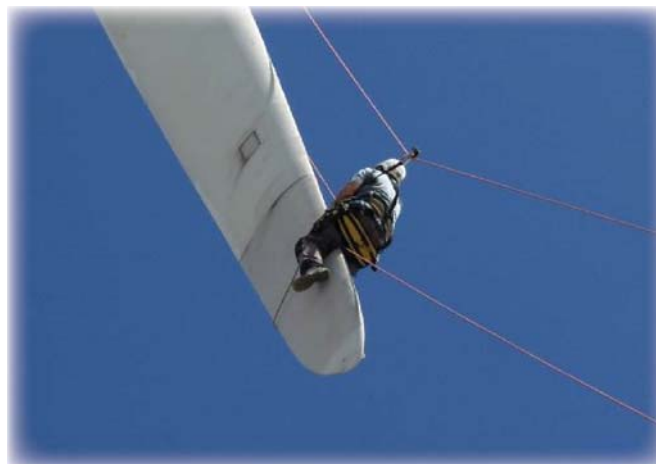
Photographie 5 : Inspection d'une pale sur le parc éolien d'Avignonet-Lauragais (Source : Boralex)
