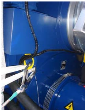
S'attacher en revêtant l'équipement antichute et en le fixant à un point d'ancrage prévu à cet effet à proximité de la sortie de secours.
