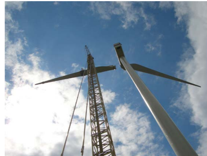
Photographie 23 : Assemblage d'une pale
