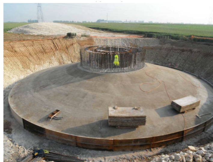
Photographie 12 : Coulage du béton sur l'armature
