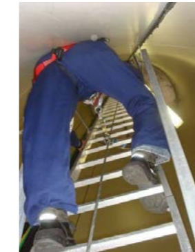
Passer de l'autre côté de l'échelle et accrocher le dispositif antichute au support d'assurage rigide.
