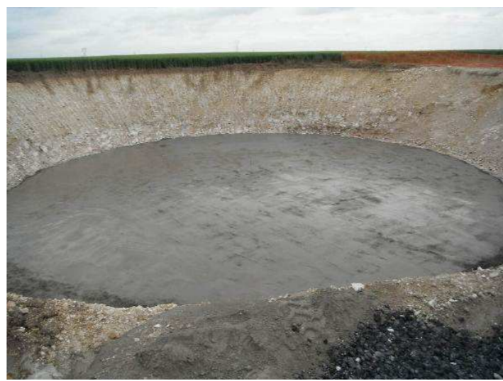
Photographie 9 : Béton de propreté avant le montage de l'armature de ferraille
