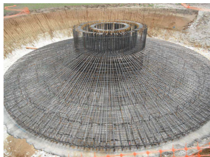
Photographie 11 : Armature d'acier de la fondation
