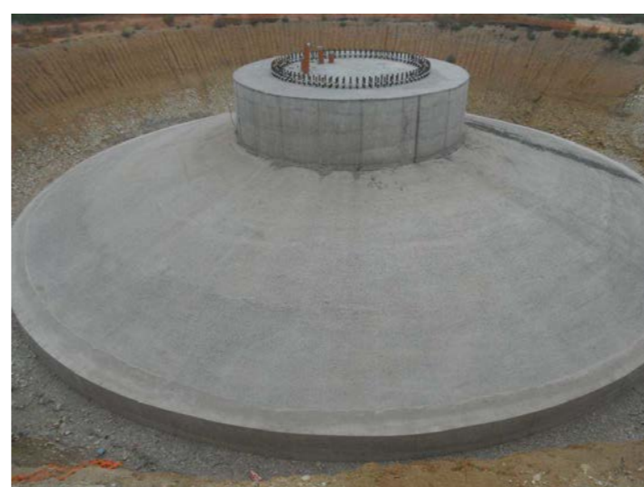
Photographie 15 : Fondation complète
