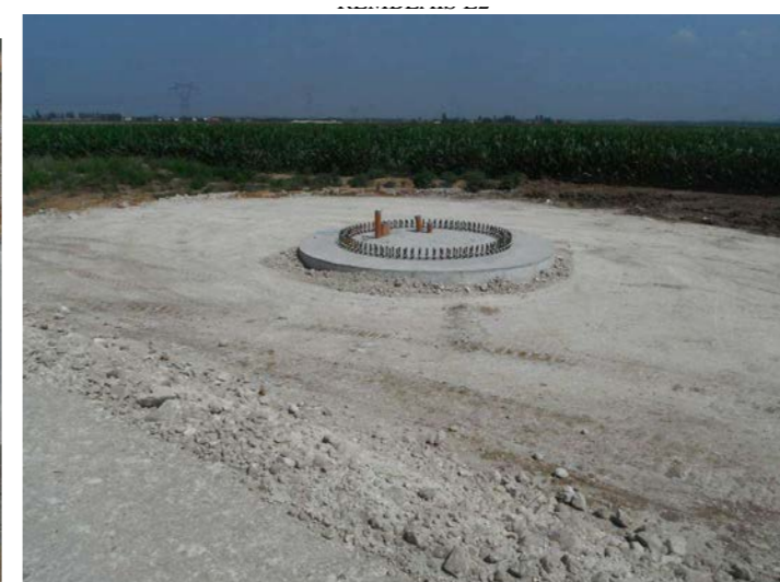
Photographie 16 : Embase de l'éolienne, fondation enterrée
