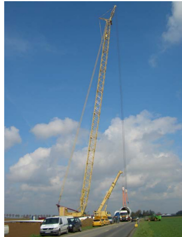
Photographie 21 : Levage d'une section de mât par la grue principale assistée de la grue auxiliaire
