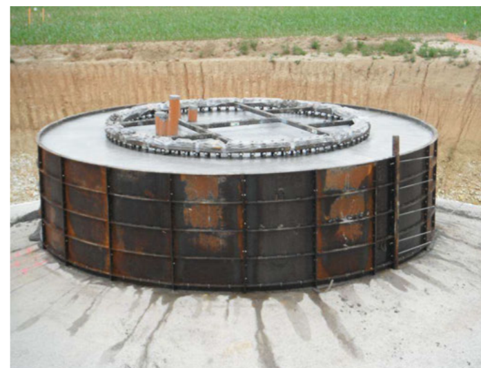
Photographie 13 : Béton solidarissant la caisse d'ancrage, caractéristique des machines Siemens, au massif
