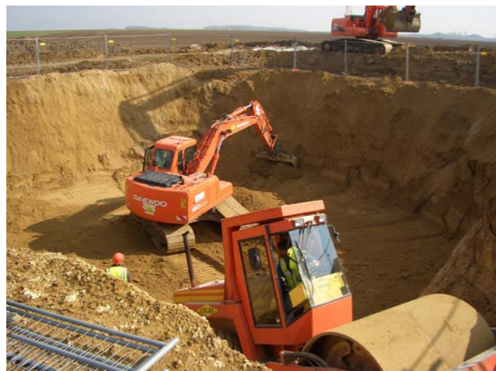
Photographie 8 : Excavation et terrassement pour l'installation des fondations
