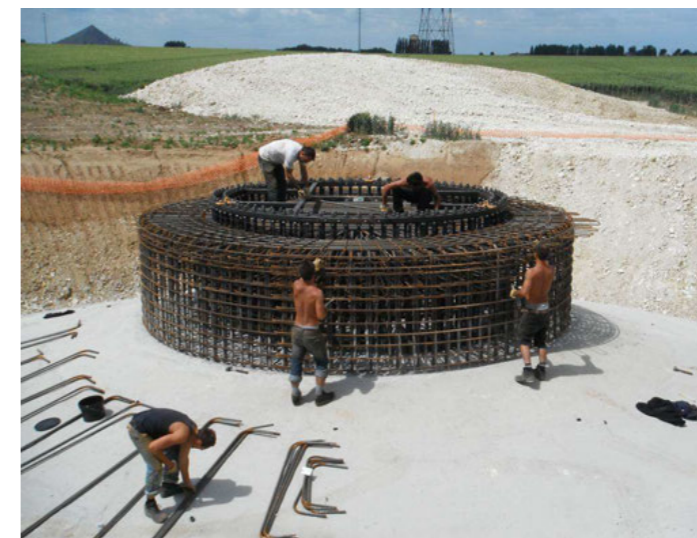
Photographie 10 : Armature d'acier de la fondation
