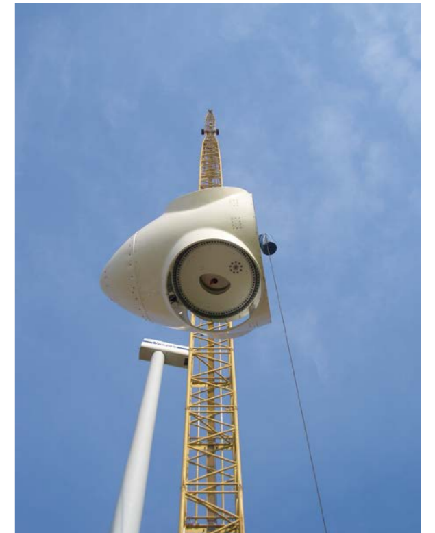
Photographie 25 : Levage du moyeu en fonte
