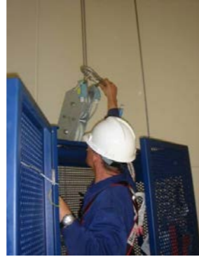
Accrocher le mousqueton à un point d'ancrage sécurisé.
