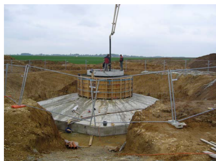
Photographie 14 : Coulage du béton solidarissant la virole, caractéristique des machines de type Vestas, au massif
