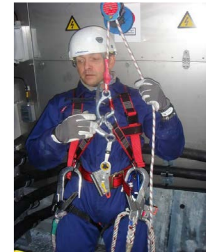
Accrocher l'équipement de descente d'urgence aux anneaux en D situés à l'avant du harnais et tirer sur la corde pour la tendre.
