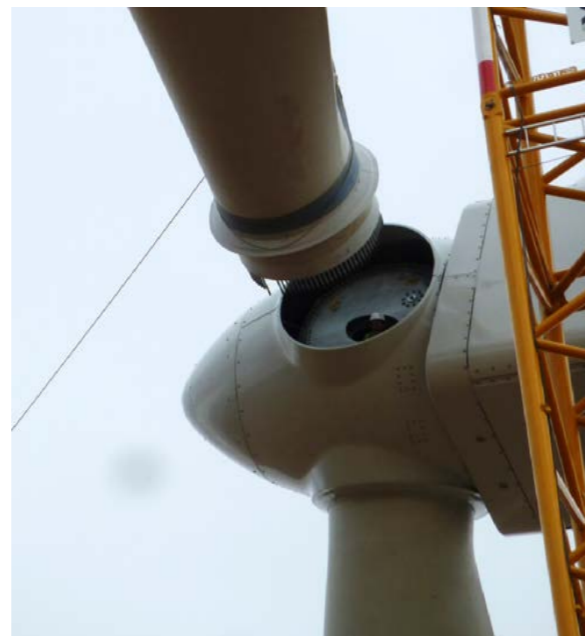
Photographie 29 : Fixation de la pale au moyeu
