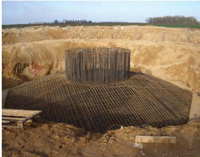
Photographie 14 : Réserve pour béton de calage 1
