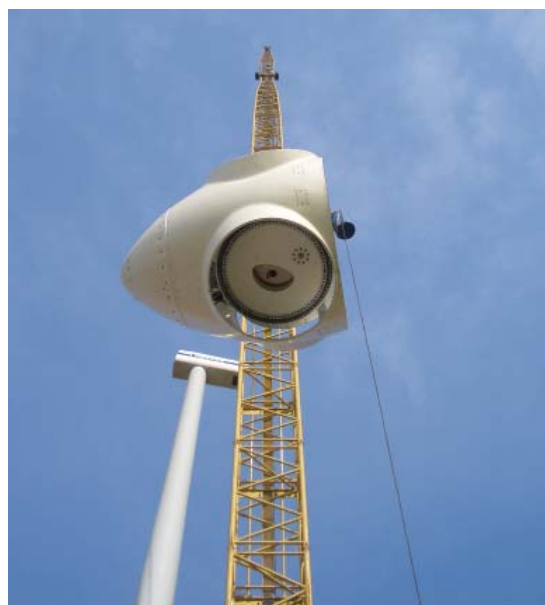
Photographie 32 : Levage du moyeu
