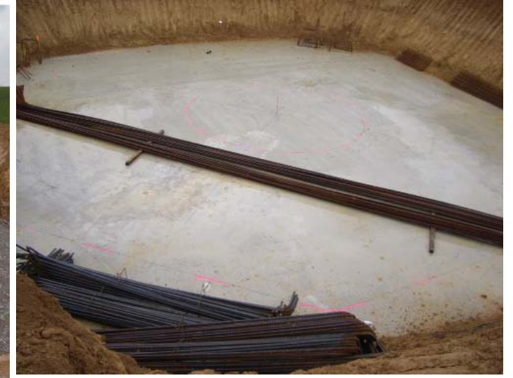
Photographie 13 : Béton de propreté avant le montage de l'armature de ferraille 1
