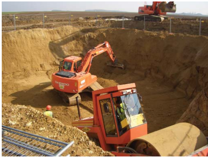
Photographie 10 : Excavation et terrassement pour l'installation des fondations 1
