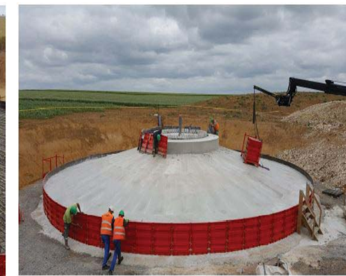
Photographie 20 : Décoffrage du massif 3
