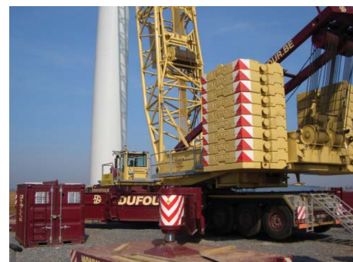
Photographie 26 : Grue principale sur l'aire de grutage, 180 t de contrepoids assure sa stabilité 1
