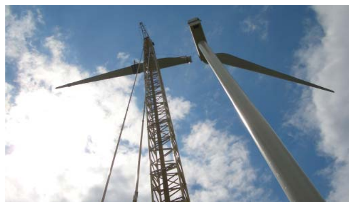
Photographie 31 : Assemblage d'une pale
