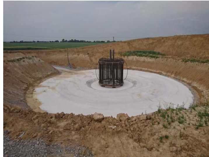
Photographie 15 : Béton de propreté et cage d'ancrage 3
