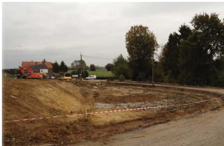
Photographie 4 : Travaux de terrassement d'un pan coupé (Source : BORALEX)
