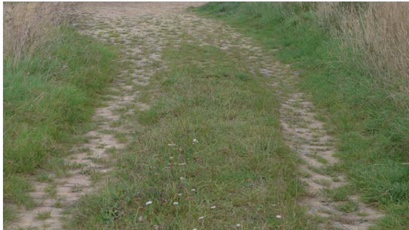
Photographie 56 : Chemin Perjet et ses pavés recouverts peu à peu par la terre
