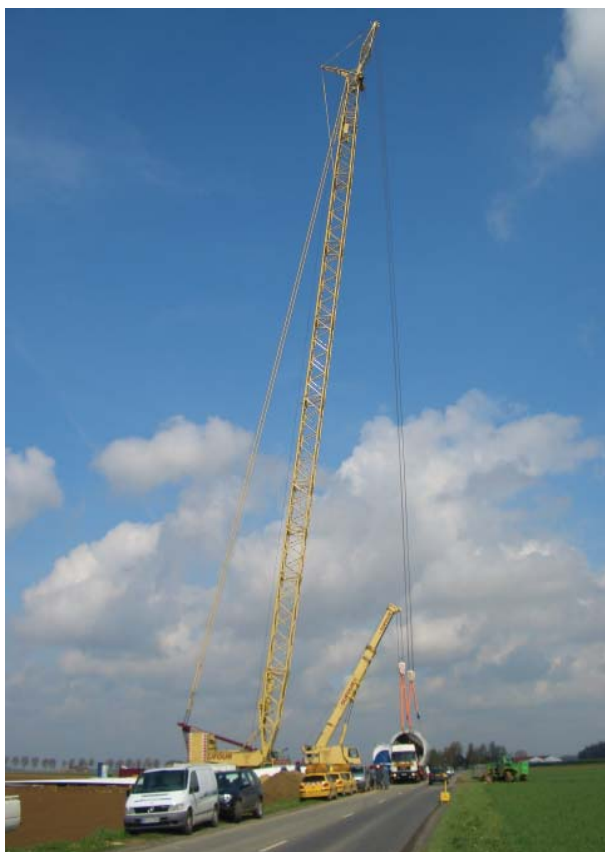
Photographie 28 : Levage d'une section de mât par la grue principale assistée de la grue auxiliaire
