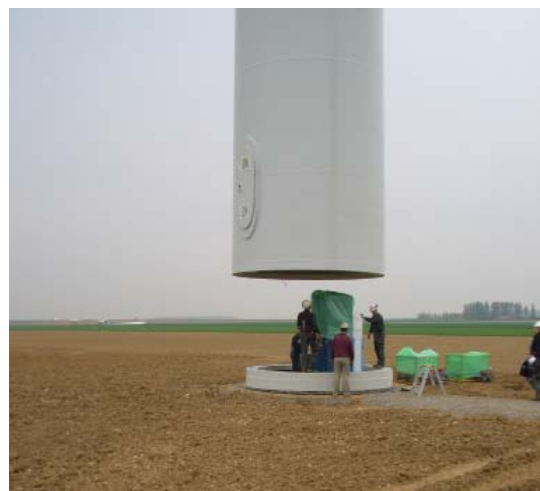
Photographie 29 : Ajustement de la première section de mât sur l'embase
