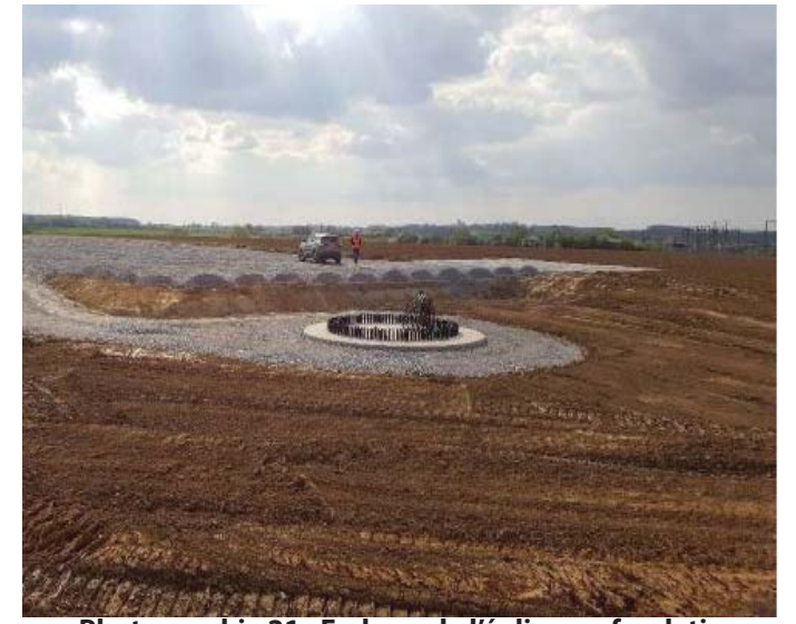
Photographie 21 : Embase de l'éolienne, fondation enterrée, Remblaiement. 2
