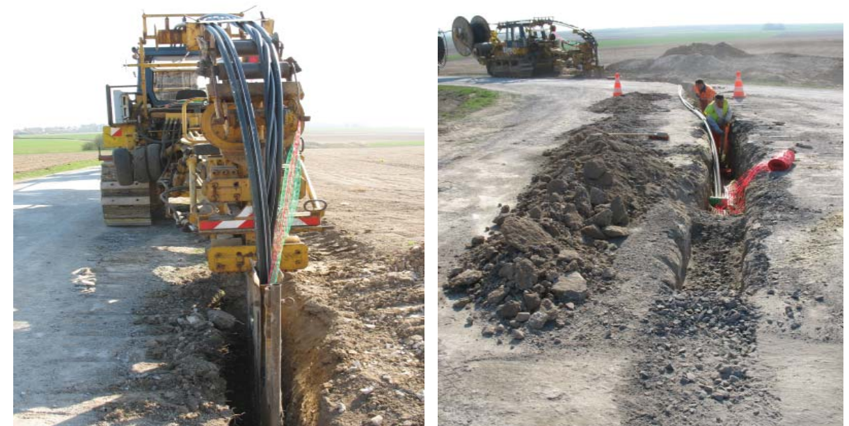
Photographie 9 : Pose de câbles dans une tranchée
