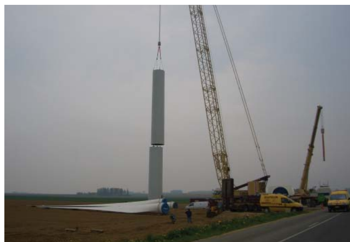
Photographie 30 : Assemblage des deux premières sections du mât
