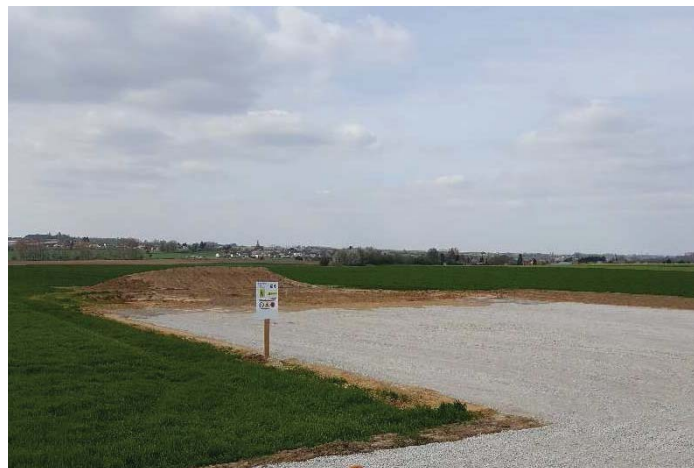
Photographie 5 : Aire de grutage aménagée (Source : BORALEX)
