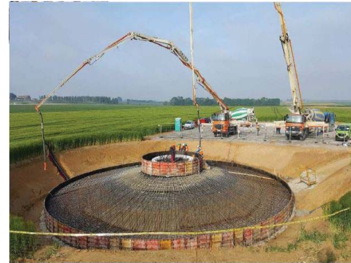
Photographie 16 : Coulage de béton sur l'armature en cours 3
