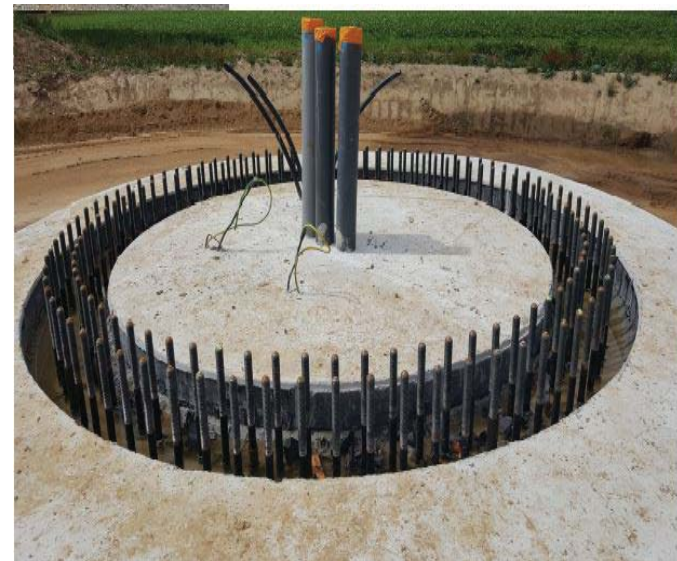
Photographie 18 : Réserve pour béton de calage 3
