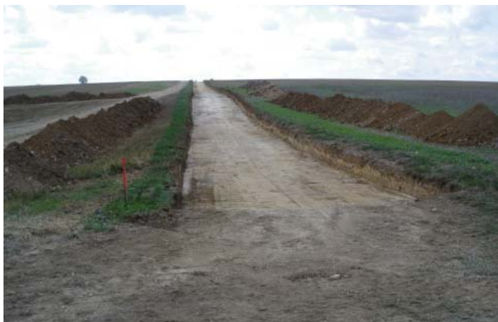
Photographie 6 : Travaux de terrassement d'une voirie (Source : BORALEX)
