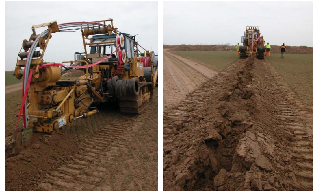
Photographie 8 : Pose de câbles à l'aide d'un soc vibrant
