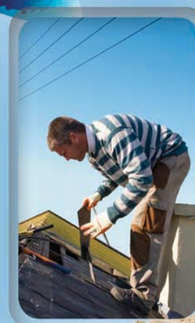
Peinture, couverture, manutention sur les toits
