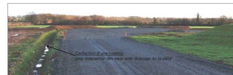
Figure 7 : exemple cunette réalisée en bordure de voirie
