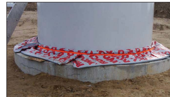
Figure 25 : Protection après Sealing de l'Anchor Cage
