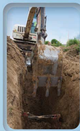
Réalisation d'une tranchée
