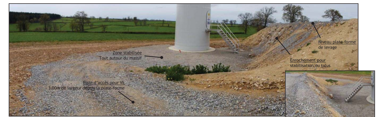
Figure 41 : Massif en contre-bas de la plate-forme avec enrochement
