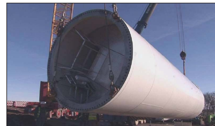
Figures 43 : Schémas, plans d'opérations de retournements fûts / Photo retournement
