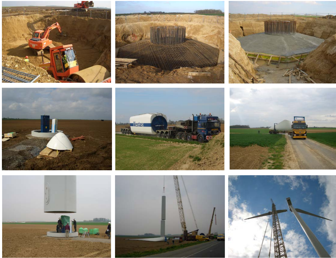
Photographie 1 : Aperçu des différentes phases de travaux
