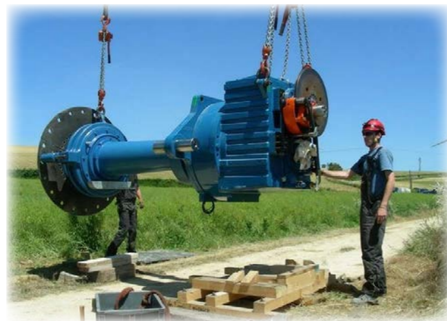
Photographie 4 : Changement d'une génératrice sur le parc éolien d'Avignonet-Lauragais (Source : Boralex)
