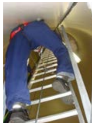
Passer de l'autre côté de l'échelle et accrocher le dispositif antichute au support d'assurage rigide.
