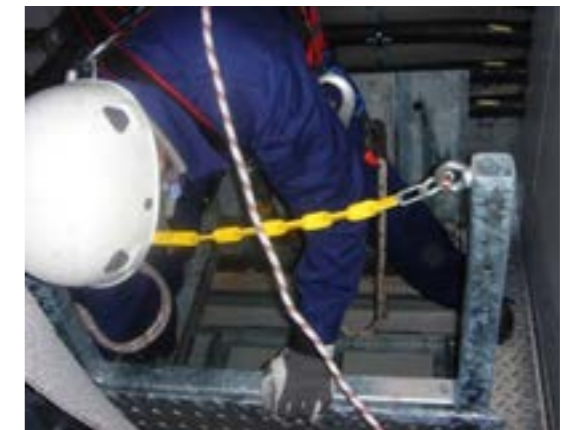
Ouvrir les panneaux de sortie de secours dans la nacelle.
