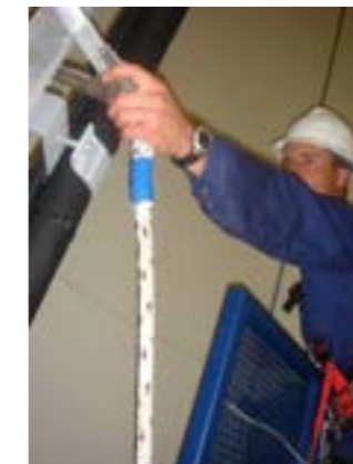
Fixer le mousqueton de la longe de maintien autour des montants de l'échelle.
