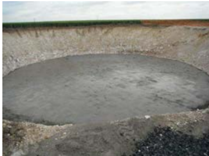
Photographie 14 : Béton de propreté avant le montage de l'armature de ferraille
