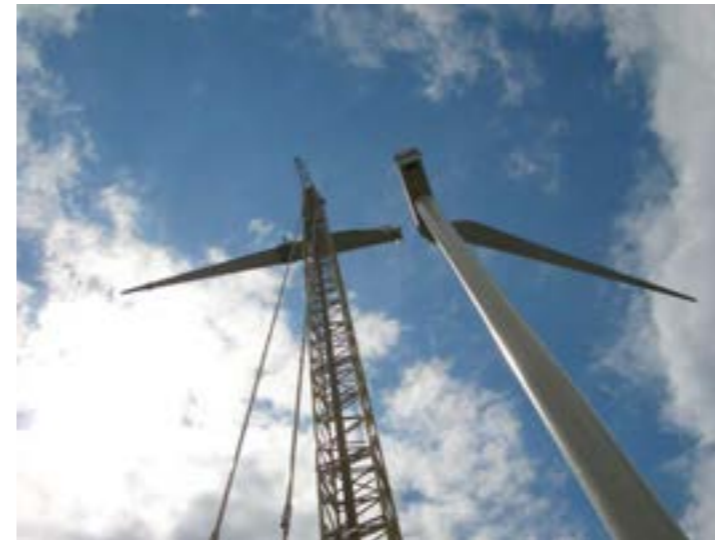
Photographie 25 : Assemblage d'une pale
