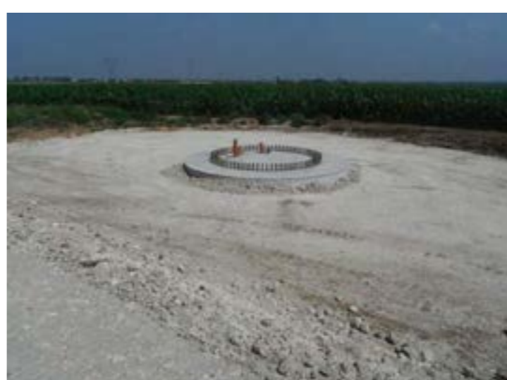
Photographie 18 : Embase de l'éolienne, fondation enterrée
