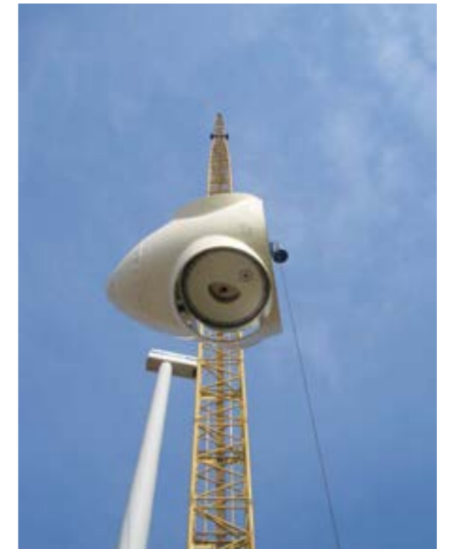
Photographie 27 : Levage du moyeu en fonte
