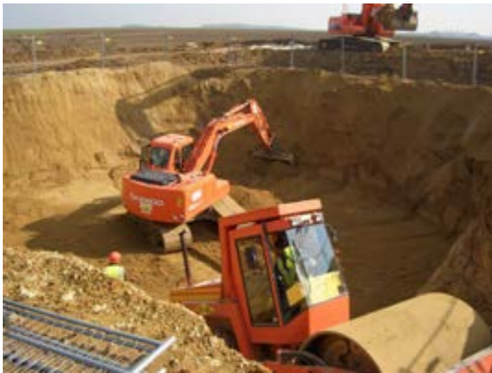
Photographie 20 : Excavation et terrassement pour l'installation des fondations
