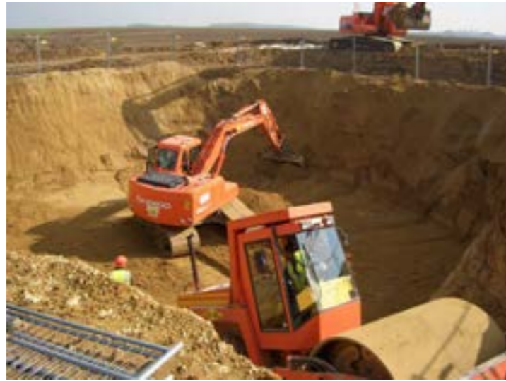
Photographie 13 : Excavation et terrassement pour l'installation des fondations
