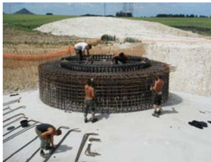
Photographie 15 : Armature d'acier de la fondation
