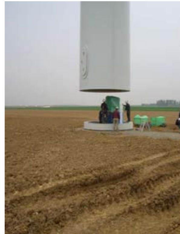
Photographie 24 : Ajustement de la première section de mât sur l'embase
