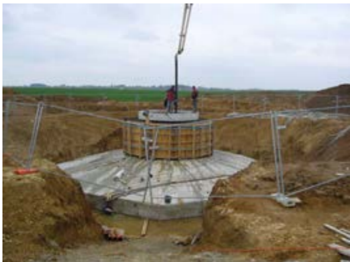
Photographie 21 : Coulage du béton solidarissant la virole au massif
