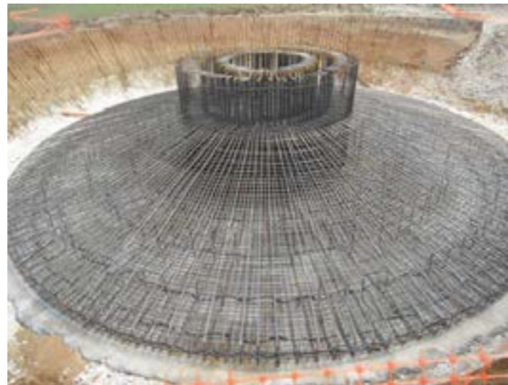
Photographie 10 : Ferrailage de la fondation finalisé
