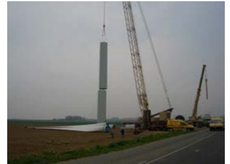
Photographie 26 : Assemblage des deux premières sections du mât
