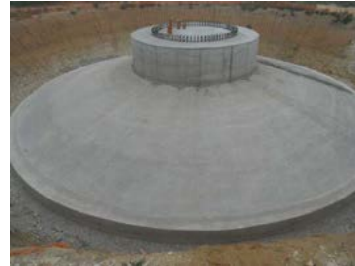
Photographie 11 : Fondation complète
