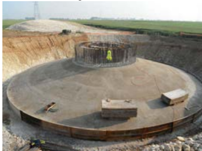
Photographie 16 : Coulage du béton sur l'armature
