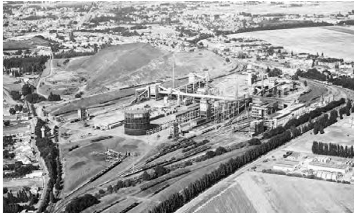
ancienne cockerie de Drocourt démantelée en 2004
