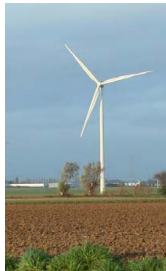
modèle Siemens SWT-101 (exemple d'éolienne présente sur le site) Rotor : 101 m Mât : 99,5 m Hauteur totale : 150 m
