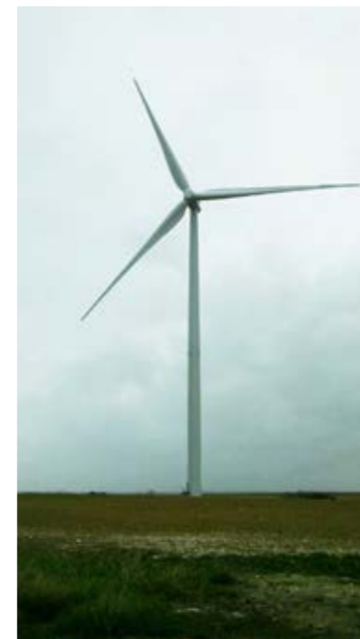
modèle d'éoliennes Siemens SWT-3.2-113 Rotor : 113 m Mât : 99,5 m Hauteur totale : 156 m
