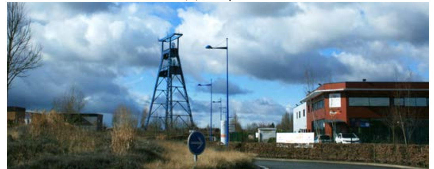
Photographie 24 : chevalement de la fosse n°9 à Roost-Warendin
