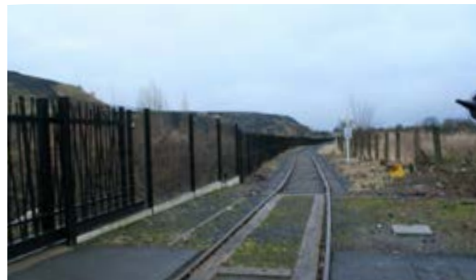
Photographie 13 : voie ferrée au niveau des terrils de Drocourt
