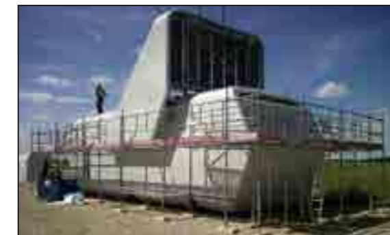
Figure 30 : Nacelle V112 en cours de préparation au sol
