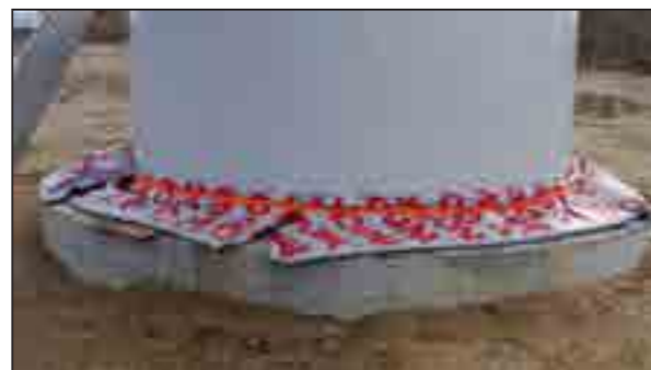
Figure 25 : Protection après Sealing de l'Anchor Cage
