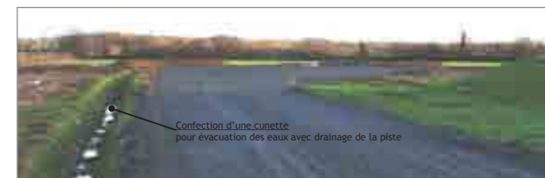
Figure 7 : exemple cunette réalisée en bordure de voirie
