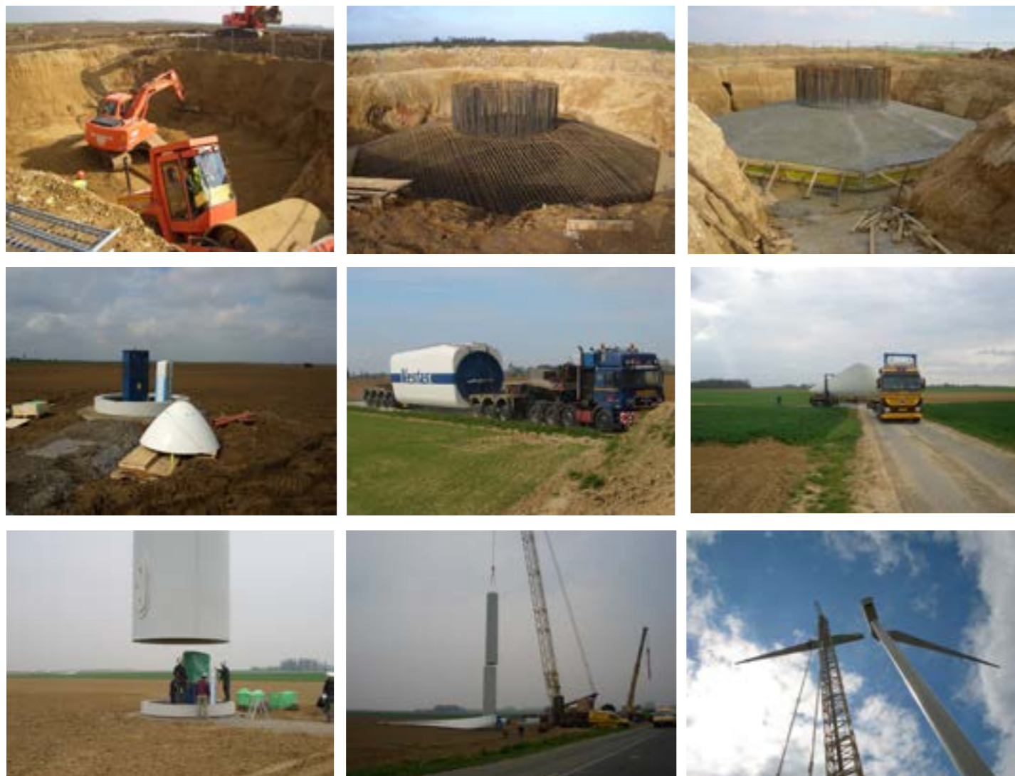
Photographie 2 : Aperçu des différentes phases de travaux
