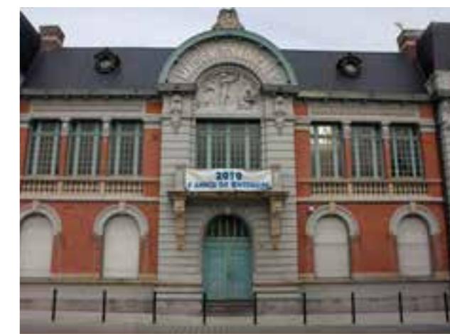
Photographie 59 : Ensemble de bâtiments de la maison syndicale des mineurs de Lens (62)
