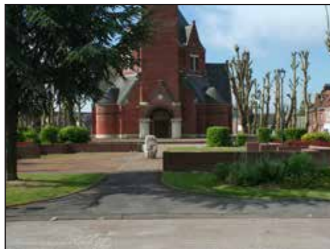
Photographie 52 : Eglise Saint-Louis de Rouvroy (62)
