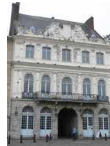
Photographie 57 : Hôtel du Dauphin à Douai (59)
