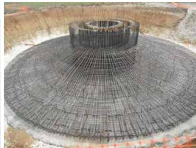
Photographie 13 : Armature d'acier de la fondation <sup>2</sup>
