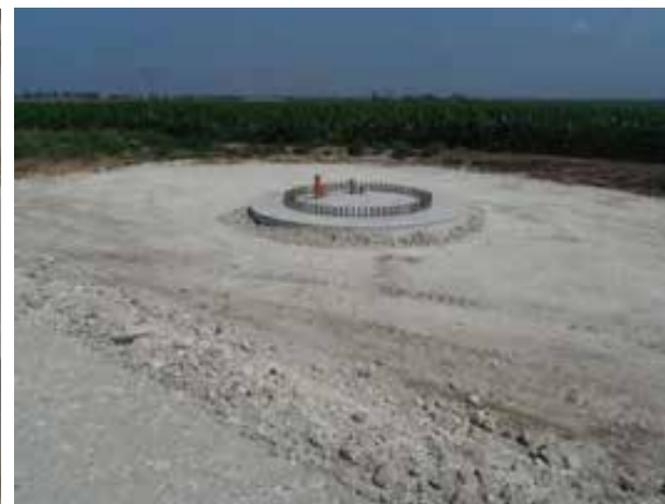
Photographie 12 : Embase de l'éolienne, fondation enterrée <sup>2</sup>
