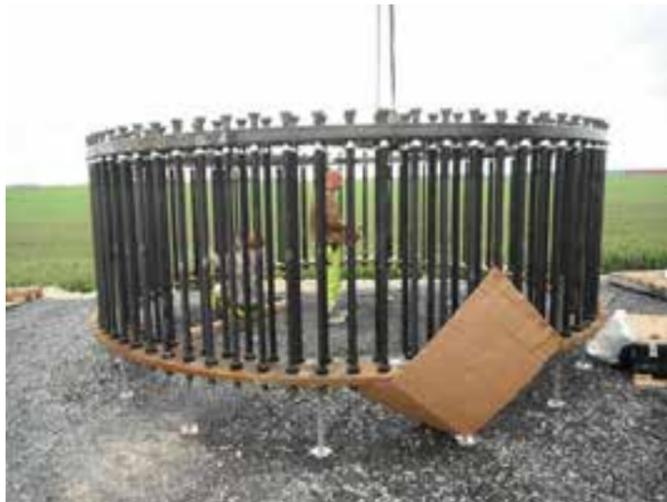
Photographie 8 : Caisse d'ancrage (embase) de l'éolienne, stockée sur une aire stabilisée <sup>2</sup>
