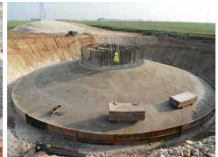
Photographie 16 : Coulage de béton sur l'armature <sup>2</sup>
