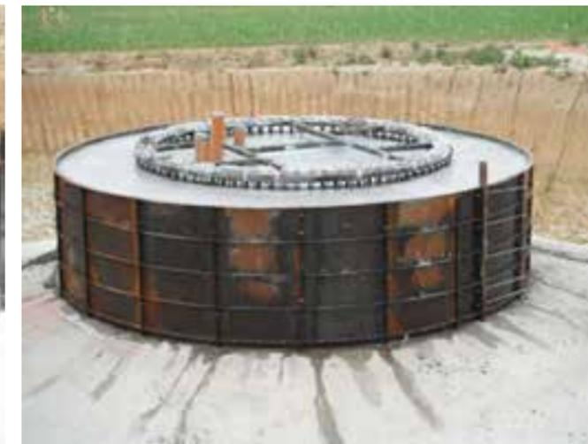
Photographie 14 : Béton solidarisant la caisse d'ancrage au massif <sup>2</sup>
