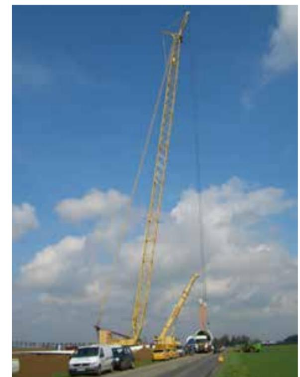
Photographie 17 : Levage d'une section de mât par la grue principale assistée de la grue auxiliaire <sup>1</sup>
