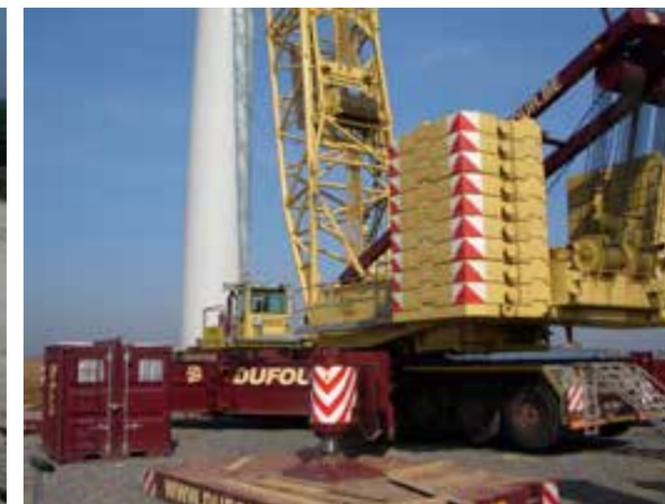
Photographie 15 : Grue principale sur l'aire de grutage, 180 t de contreponds assure sa stabilité <sup>1</sup>
