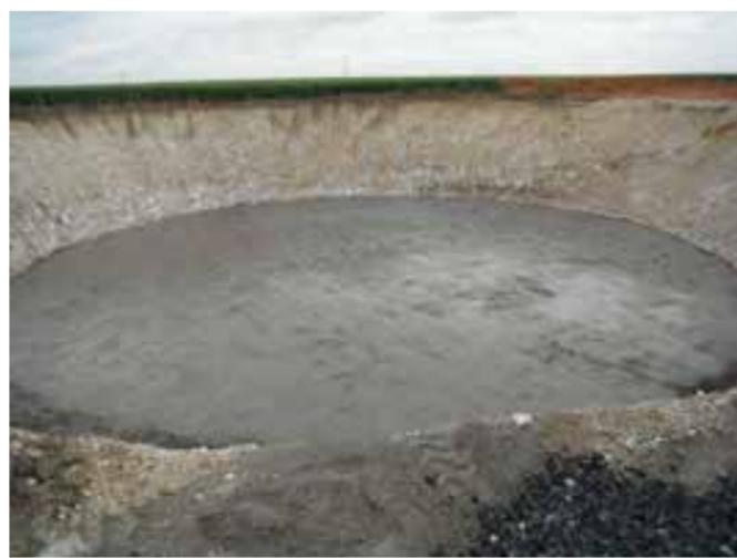
Photographie 10 : Béton de propreté avant le montage de l'armature de ferraille <sup>2</sup>
