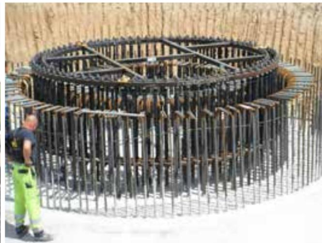
Photographie 11 : Insertion de la caisse d'ancrage dans l'armature de la fondation <sup>2</sup>
