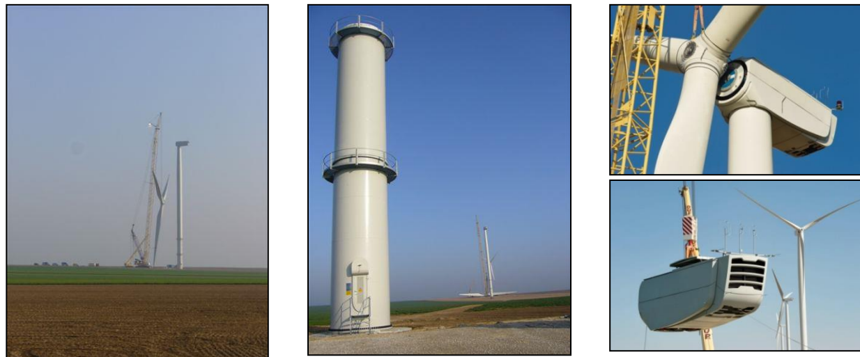
Figure 17 : Installation des éoliennes (source : Nordex, 2015)
