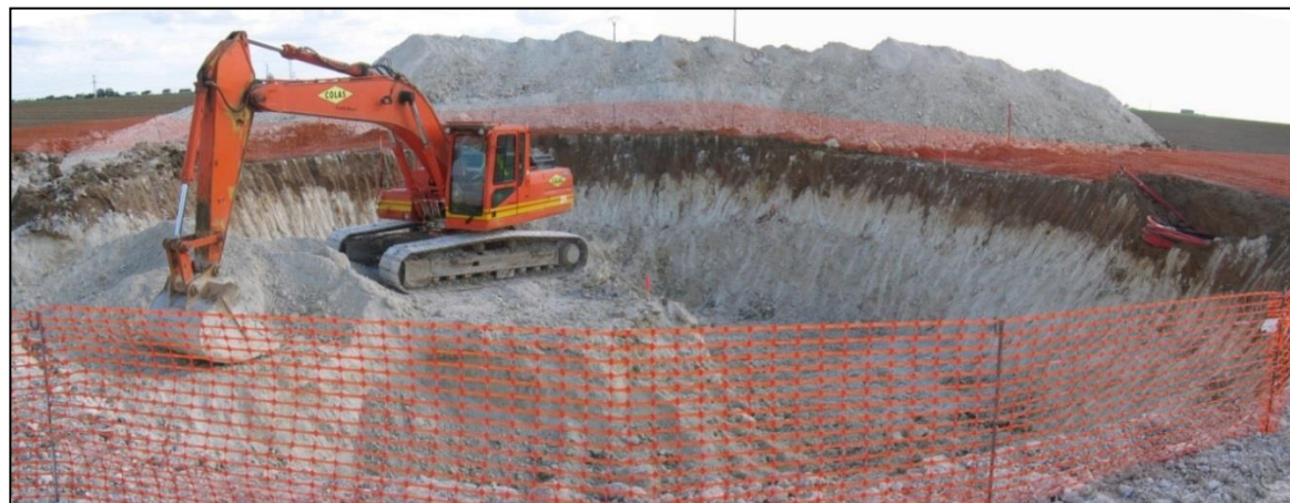
Figure 13 : Mise en place des fondations par la pelle-mécanique (source : Nordex, 2015)
