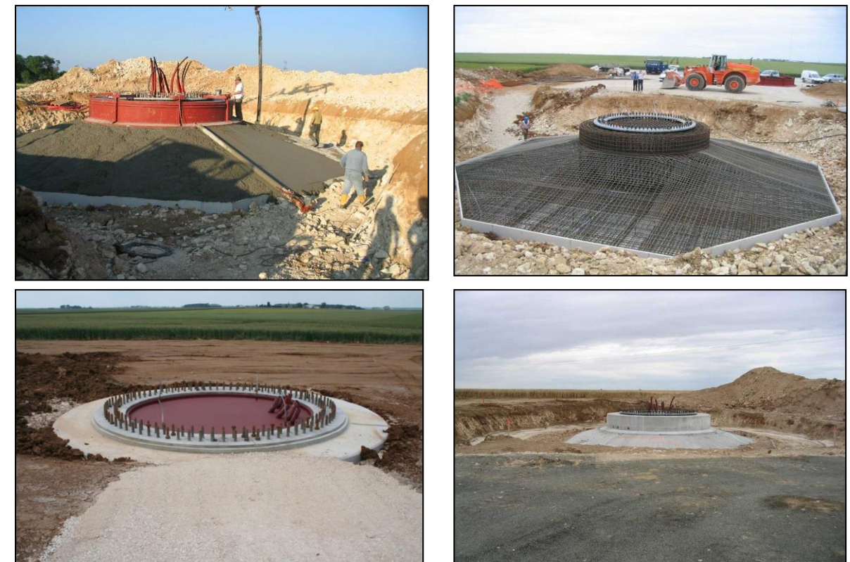
Figure 14 : Mise en place des fondations (source : Nordex, 2015)
