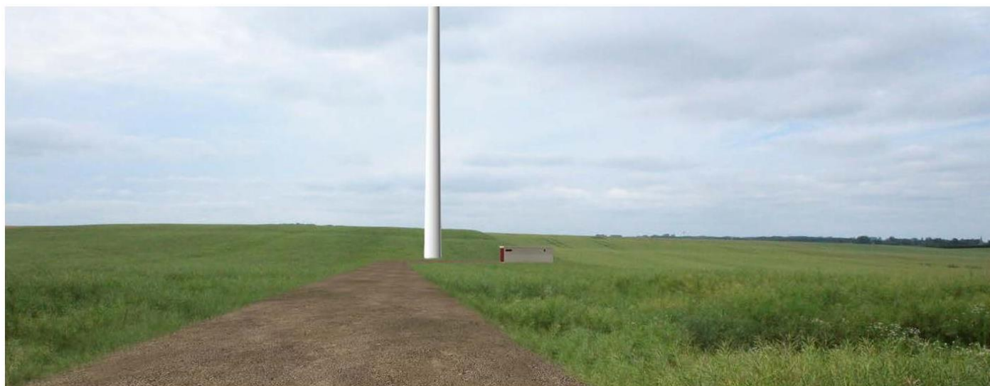
Figure 11 : Poste de livraison à proximité de l'éolienne E1 (source : Nordex, 2016)
