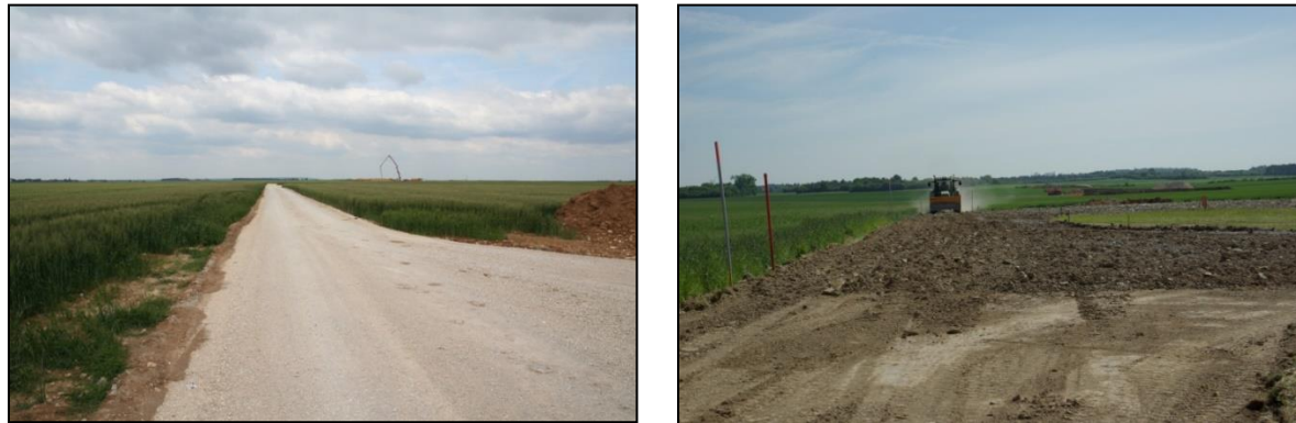
Figure 12 : Préparation des terrains (source : Nordex, 2015)
