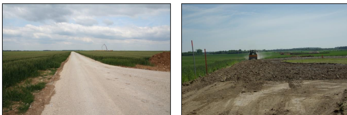
Figure 12 : Préparation des terrains (source : Nordex, 2015)
