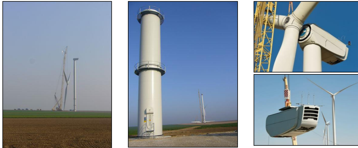
Figure 17 : Installation des éoliennes (source : Nordex, 2015)
