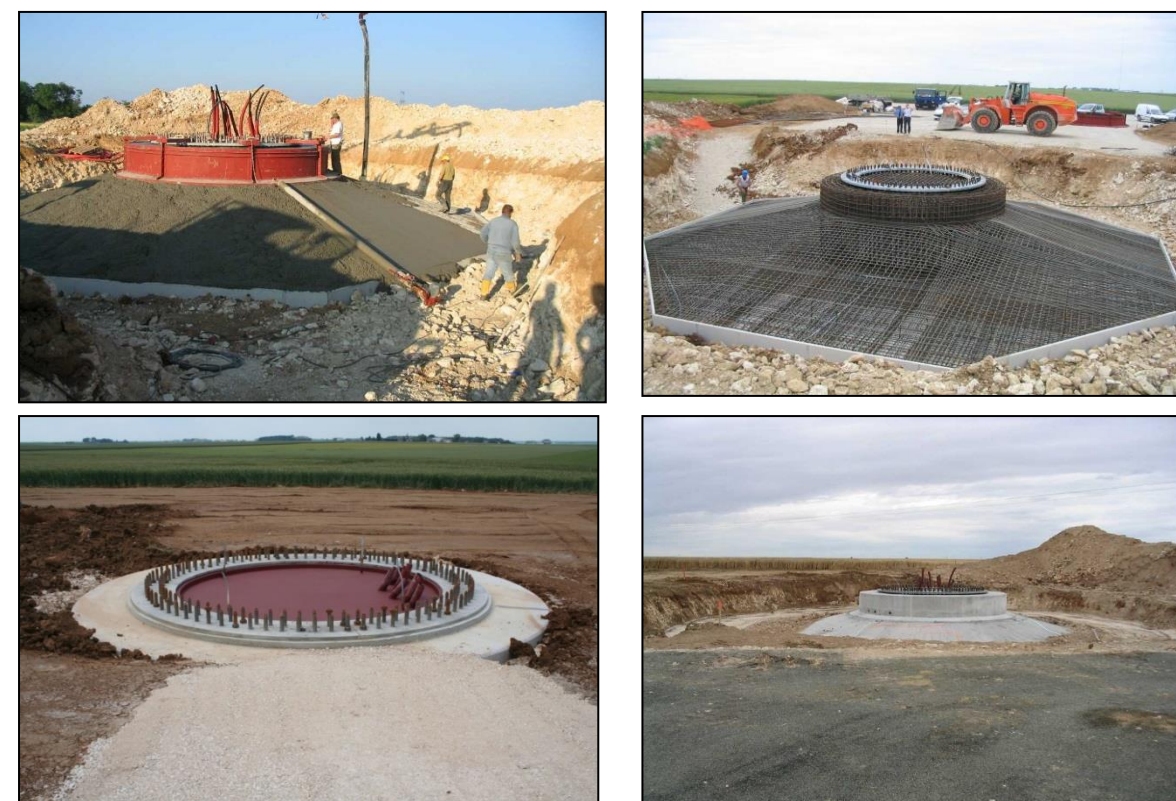
Figure 14 : Mise en place des fondations (source : Nordex, 2015)
