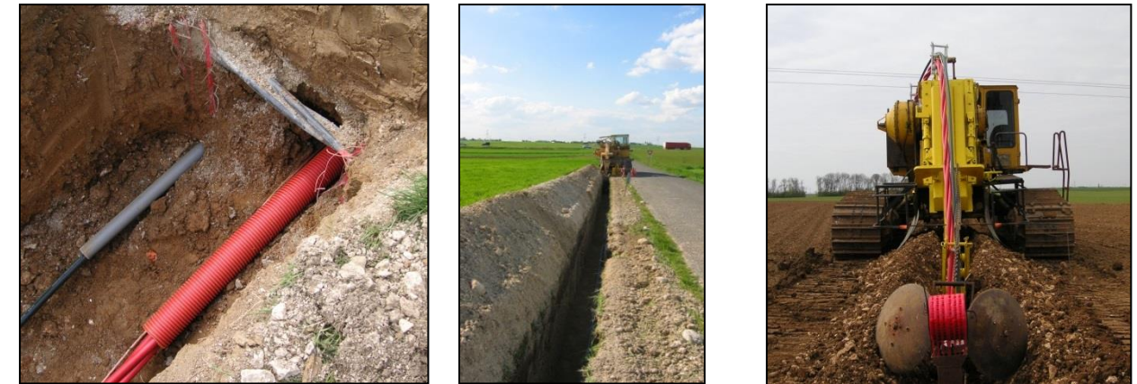
Figure 18 : Installation du raccordement électrique
