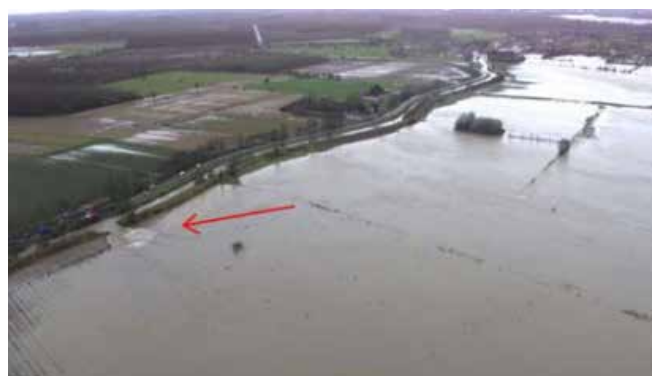
Rupture de la digue sur l'Hogneau
