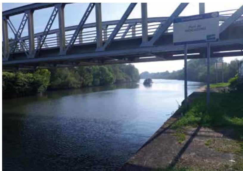
Pont du Trocadéro, situé sur le bief Denain-Trith, sur l'Escaut canalisé
