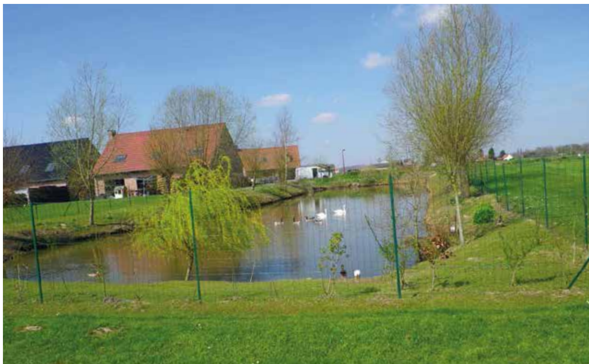
Bassin de rétention créé dans le cadre de la réalisation d'un lotissement à Brillon
