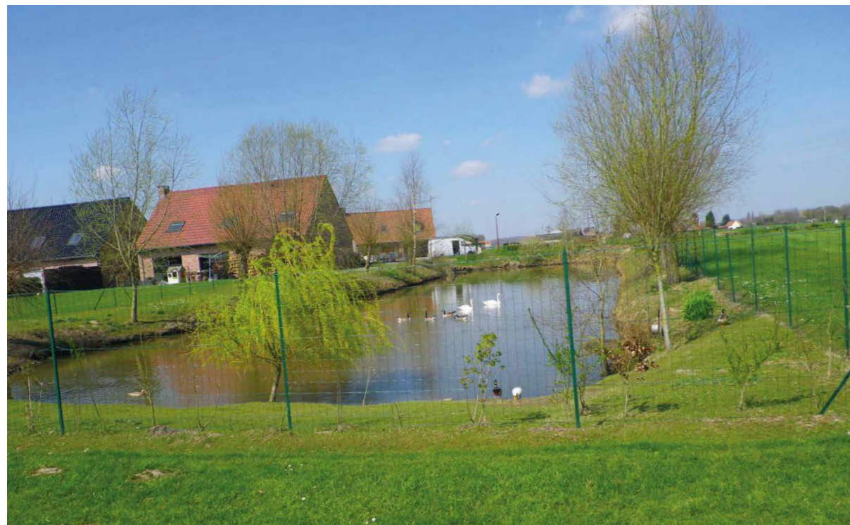
Bassin de rétention créé dans le cadre de la réalisation d'un lotissement à Brillon
