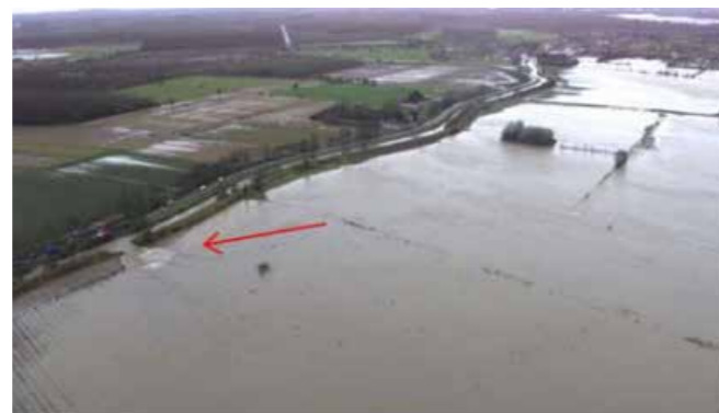
Rupture de la digue sur l'Hogneau
