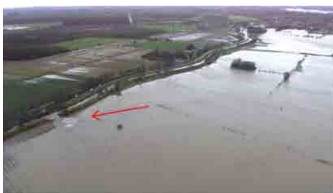
Rupture de la digue sur l'Hogneau
