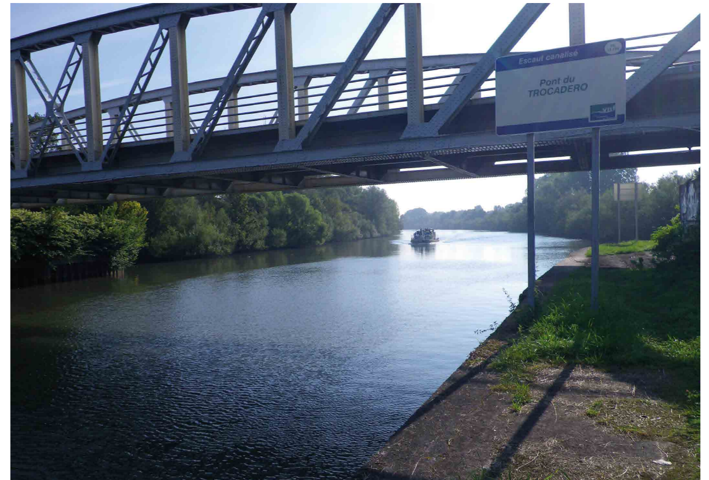
Pont du Trocadéro, situé sur le bief Denain-Trith, sur l'Escaut canalisé
