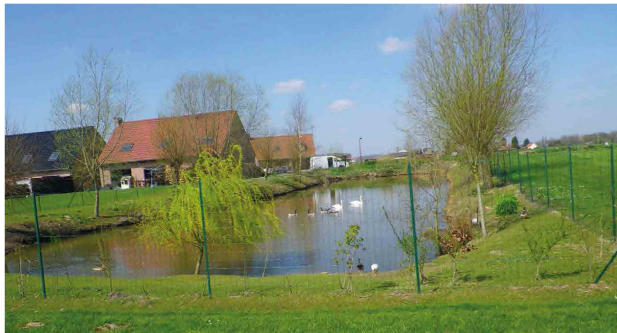
Bassin de rétention créé dans le cadre de la réalisation d'un lotissement à Brillion
