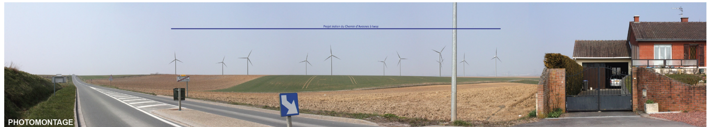
Vue 10 : RD 114, sortie ouest de Villers-en-Cauchies, à 1,6 km du projet
