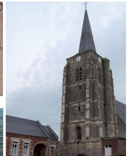
2 - Rieux-en-Cambresis : Eglise inscrite, voûtes et plafonds classés
