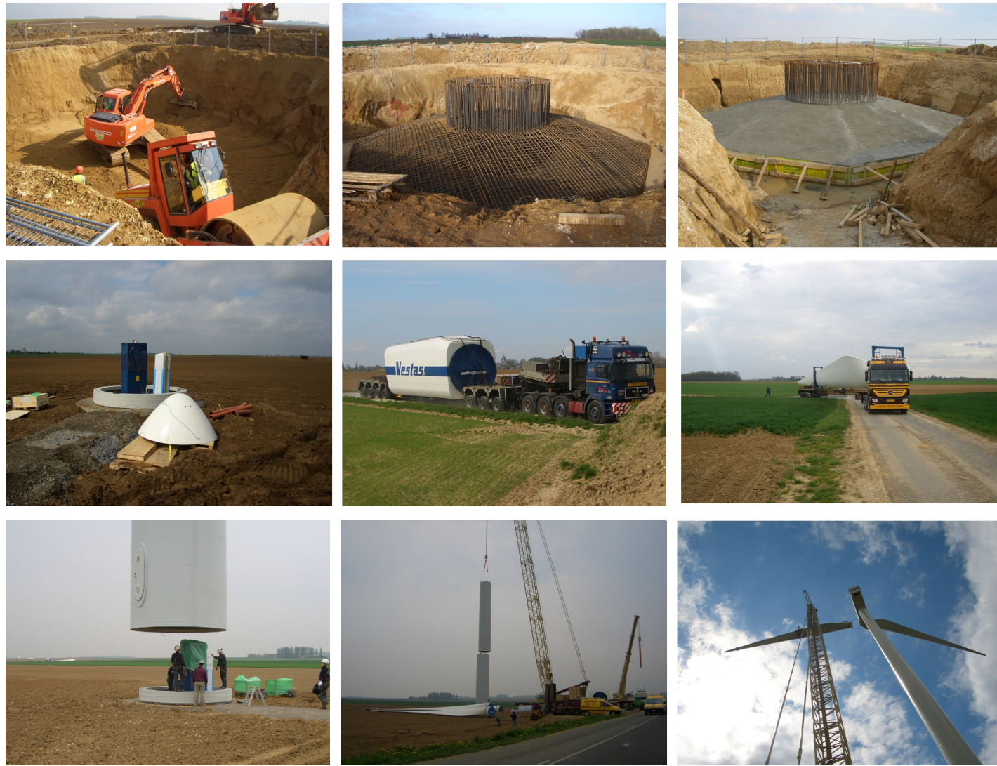
Photographie 2 : Aperçu des différentes phases de travaux
